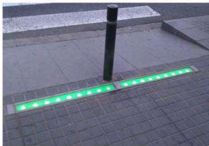
Рис. 20. Применение зелёных и красных светодиодов в качестве дополнительных сигнальных элементов к светофорам [16].
