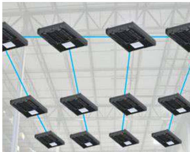
Рис. 121. Связь светильников Intelligent Light Engine в беспроводную сеть.
