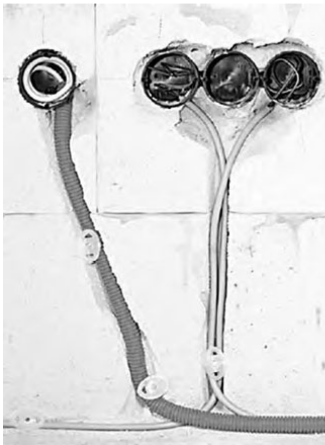
Рис. 4.13. Проводники, предварительно уложенные в трубы, могут пересекаться
