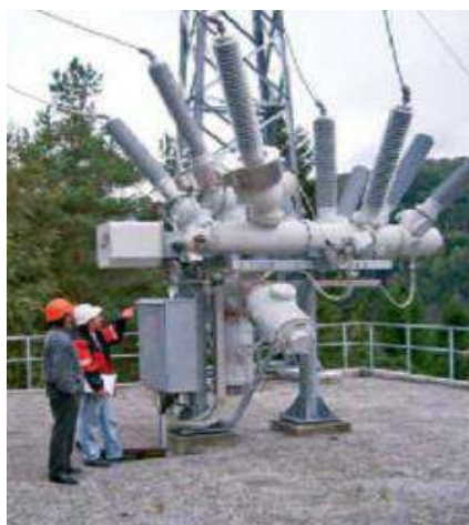
Ячейка с двумя системами СШ в Норвегии
