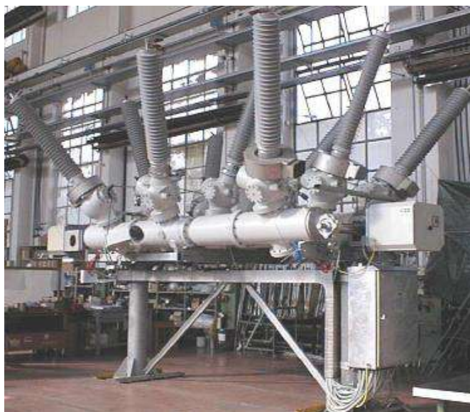
Рисунок 5.24 – Ячейка с двумя системами сборных шин
