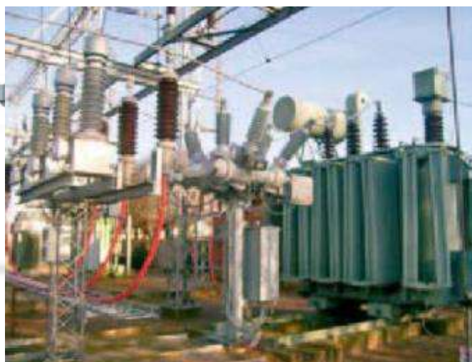
Ячейка с одной системой СШ в Дании
