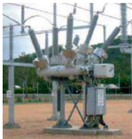
Ячейка с одной системой СШ в Австралии
