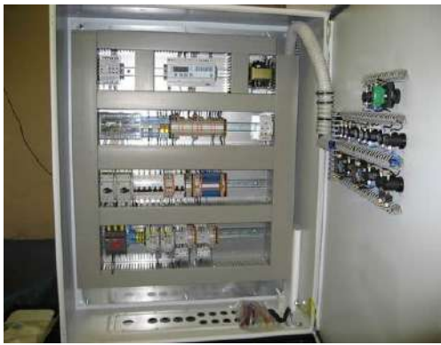
Рис.2.8. Щит управления и его схема
