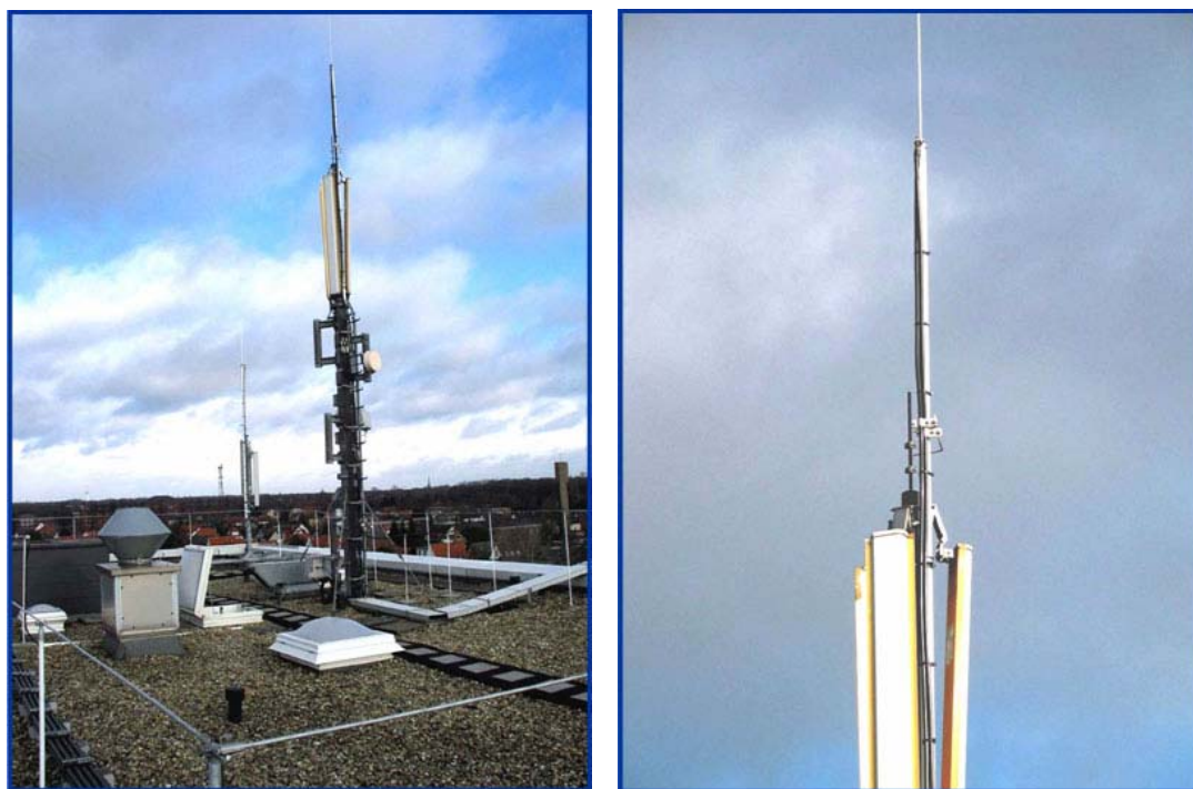
Рис. 8. Пример использования кабеля в изоляции высокого напряжения, покрытой полупроводящим материалом, для отвода тока молнии [11]
