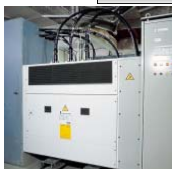
Рис.3.6. Стандартные присоединения ВН и НН сверху трансформатора защищенного исполнения.
