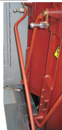
Рис.3.5. Присоединения ВН с использованием втычных разъёмов.
