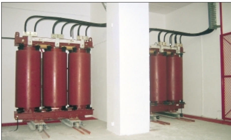
Стандартные присоединения ВН и НН сверху
