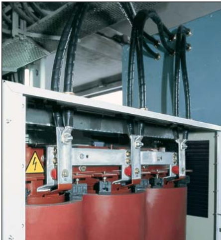
Присоединения ВН сверху через разъемы (1) (на заказ)
