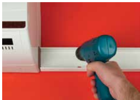
Закрепите основание короба на стене
