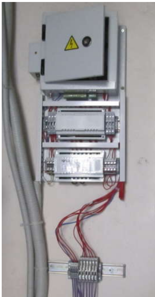
Рис.3 терминал диспетчеризации после выполнения монтажа внутри подстанции
