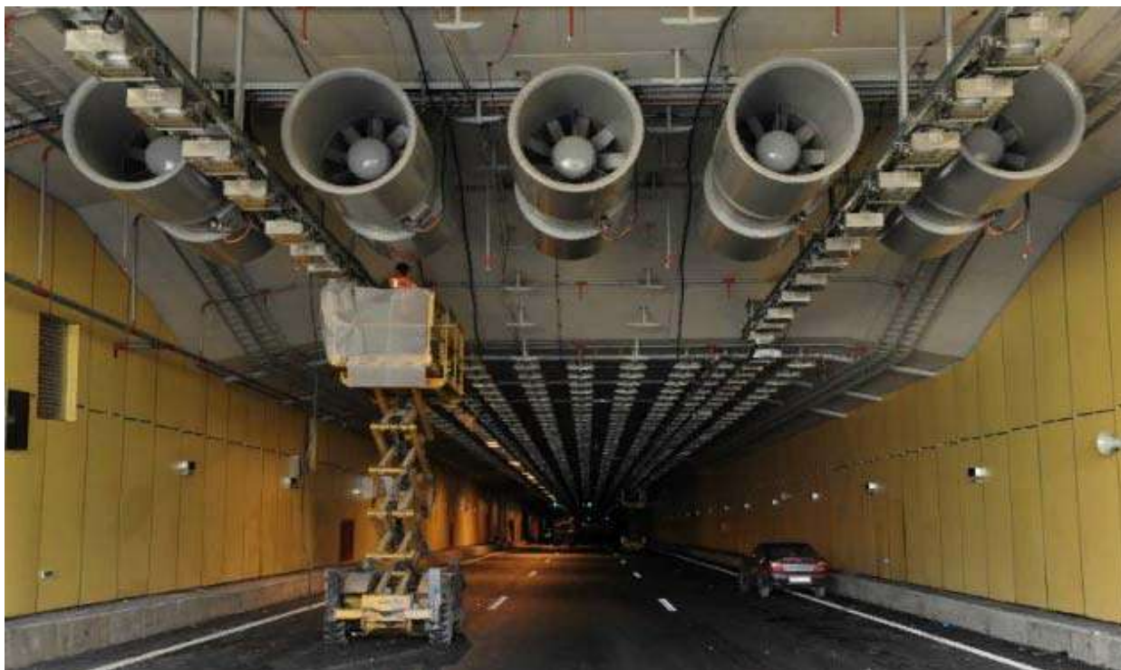
Рис. 19. Осевые вентиляторы в автодорожном тоннеле
