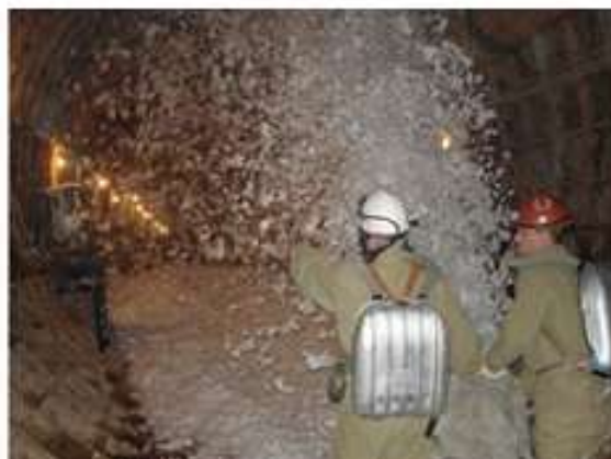
Рис. 4. Применение пеногенераторной установки
