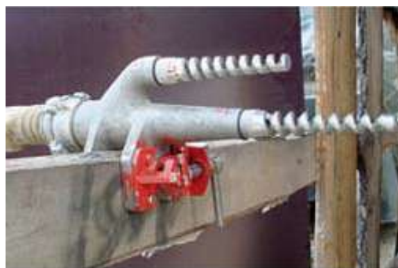
Рис. 11. Винтовой водоразбрызгиватель типа ВВР
