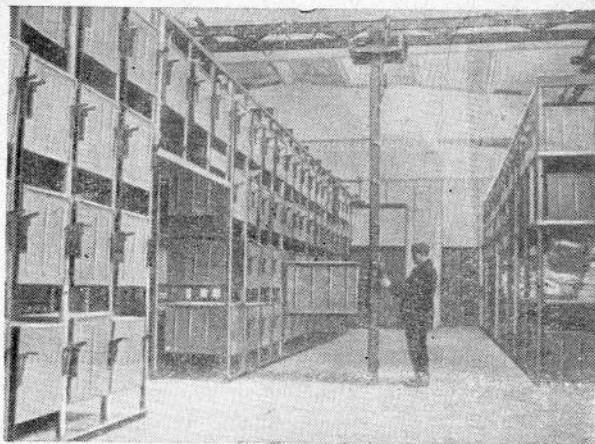
Рис. 8. Механизированный склад контейнеров с материалами для электрооборудования жилых зданий
