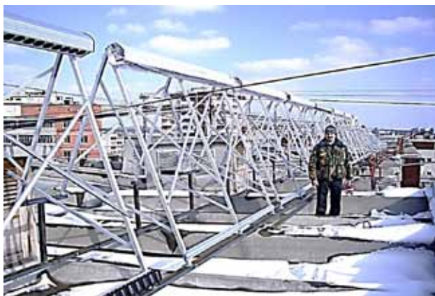
4 – насос циркуляционный ; 5 – насос питательный Рис. 4.35. Фото монтажа каркаса для солнечных вакуумных коллекторов на многоквартирном доме в Екатеринбурге (март, 2012 г.)
