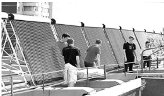
Рис. 4.36. Монтаж вакуумных солнечных коллекторов на многоквартирном 10-этажном доме в Екатеринбурге (июнь 2012 г., студенты кафедры АС и ВИЭ УрФУ на практическом занятии по монтажу.
