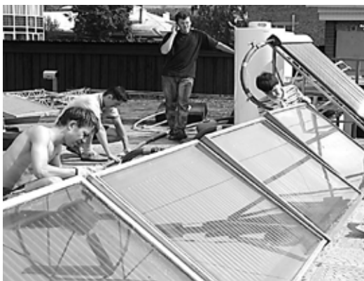
Рис. 4.22. Монтаж системы солнечных коллекторов на полигоне ВИЭ в УрФУ
