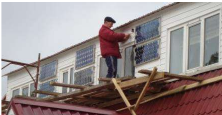
Рис. 4.15. Монтаж ФЭП на объекте «Энергоэффективный дом» (ведет заведующий кафедрой АС и ВИЭ доктор технических наук, профессор Щеклеин С. Е.)
