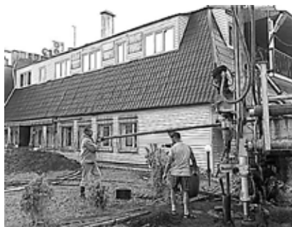
Рис. 4.82. Фрагмент монтажа скважных зондов теплового насоса для квартиры № 1 объекта «Энергоэффективный дом» (sp-КС ВИЭ)
