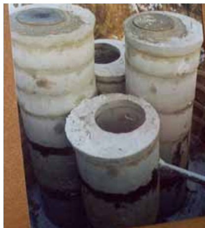
Рис. 4.68. БГУ для очистки отходов жизнедеятельности ЭЭД
