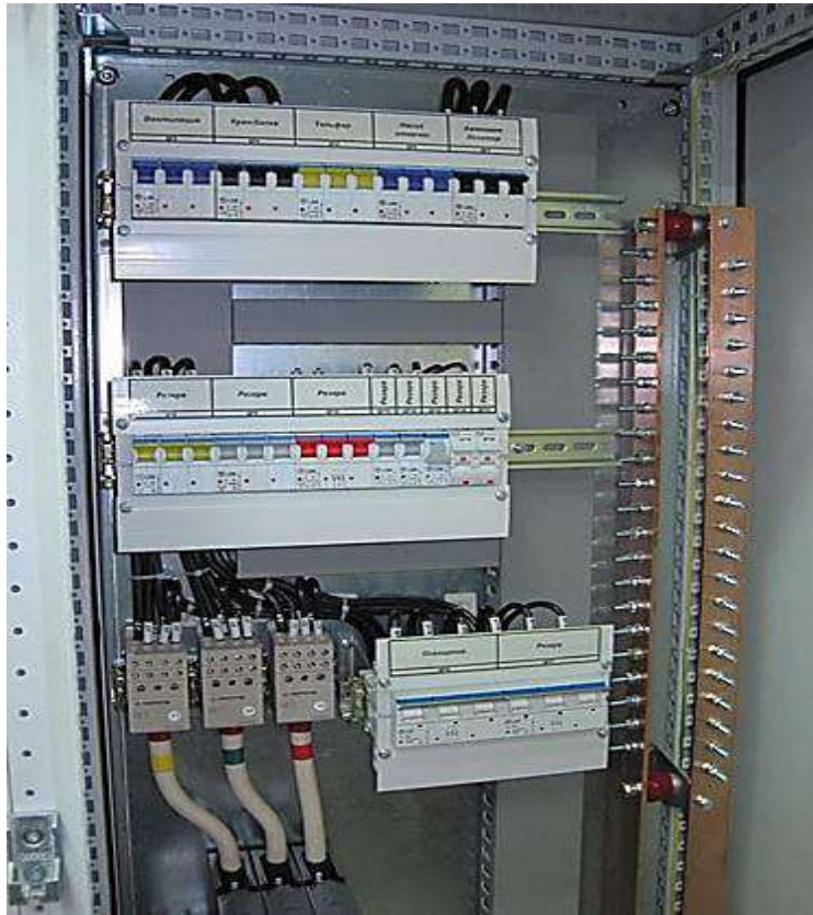
Рисунок 4.9 – Головний розподільний щит
