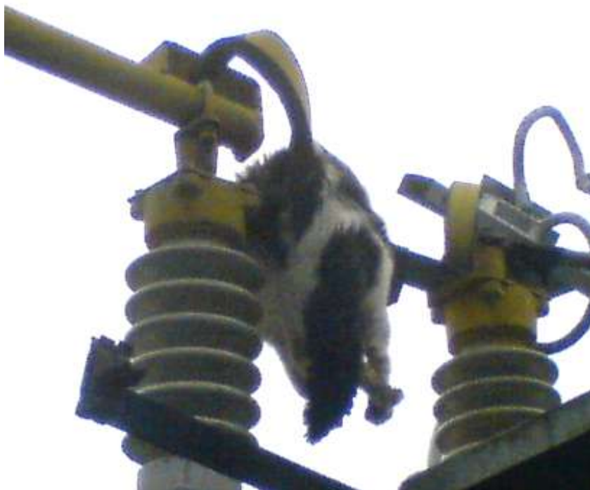
Рисунок 1.13 – Погибшее животное на высоковольтном отделителе
