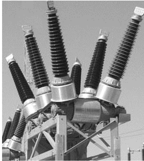
Рисунок 3.10 – Баковый элегазовый выключатель типа ЗАР1DT-145/ЕК
