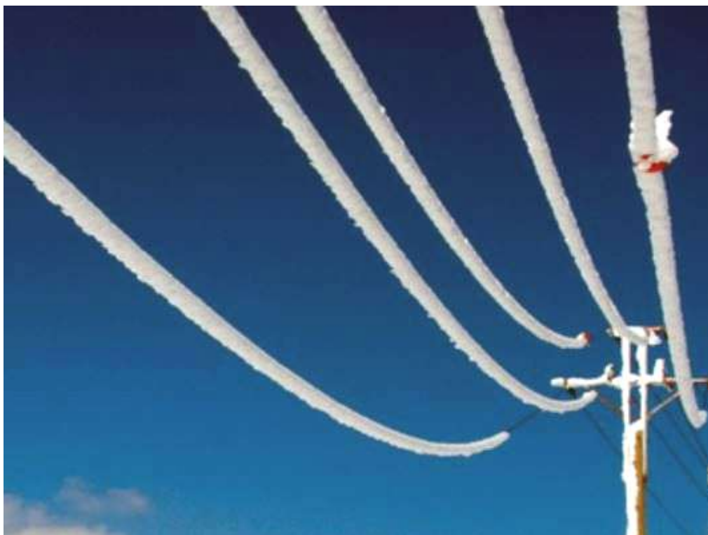
Рисунок 1.8 – Гололед и снежные образования на проводах ВЛ
