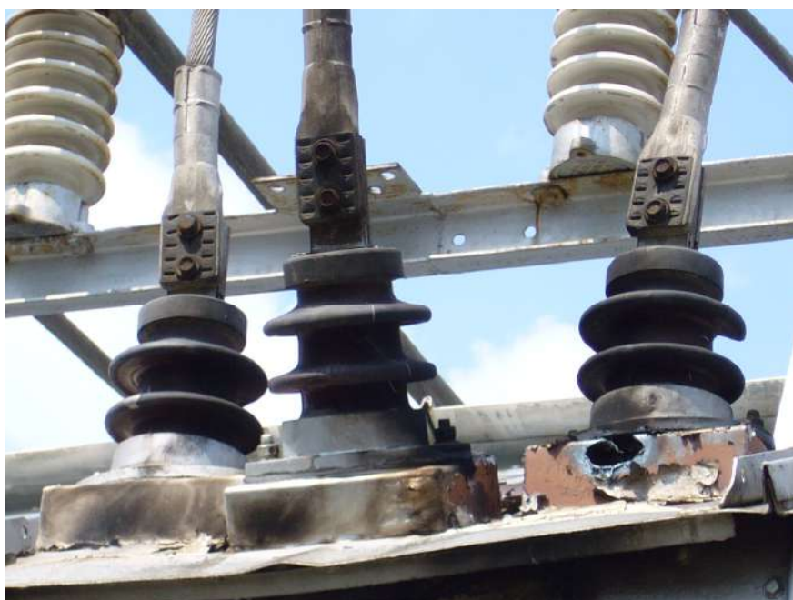
Рисунок 1.14 – Результаты перенапряжения и возникшей электрической дуги
