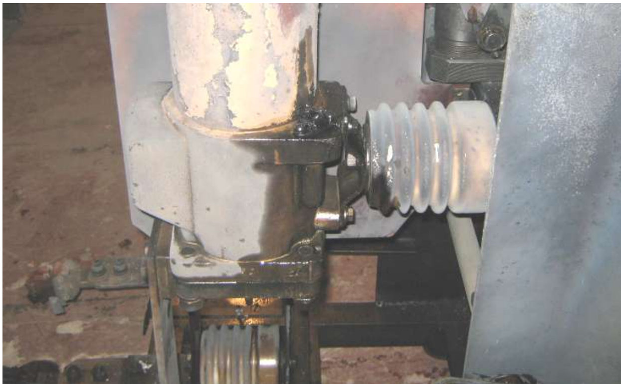
Рисунок 1.9 – Повреждение маломасляного выключателя
