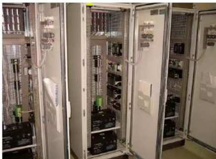
Рисунок 8.2 – Шафа телемеханіки центрального диспетчерського пункту
