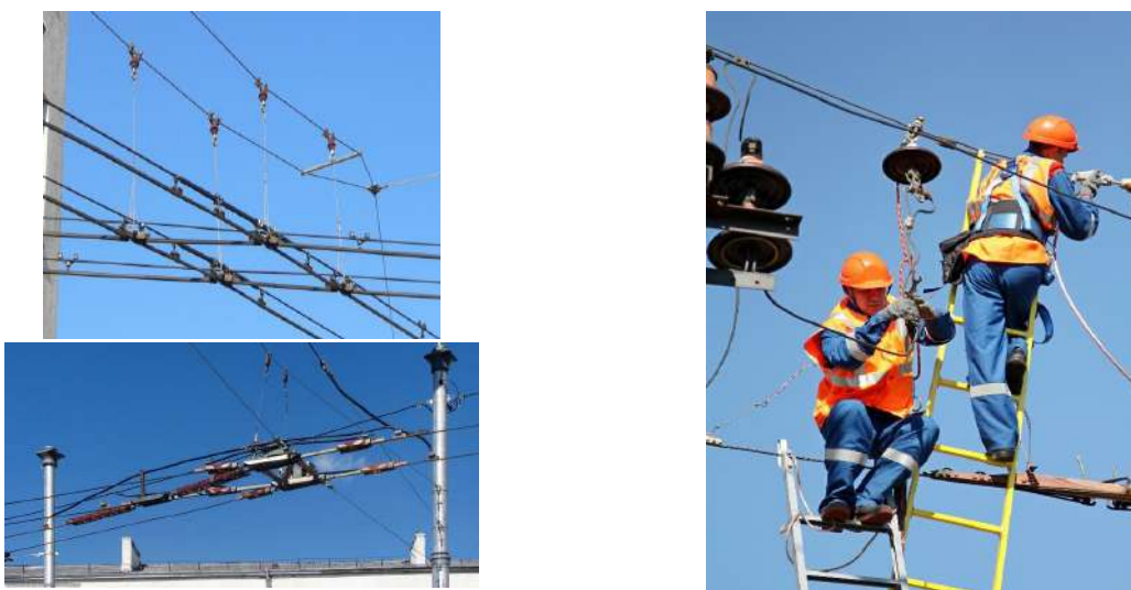
Рисунок 4.2 – Контактна мережа міського електротранспорту
