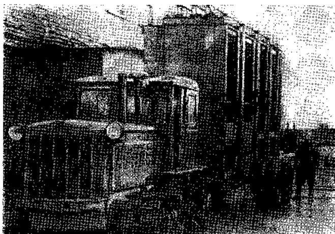
Рис. V.10. Блок камер 10 кв отгружается в монтажную зону
