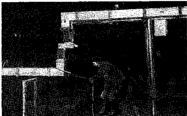
Рис. V.1. Стыковка блоков магистрального шинопровода
