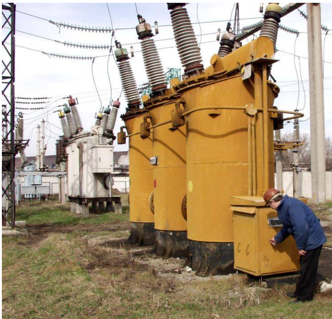
Рисунок. 2.9 - Загальний вигляд вимикача типу У-220-2000-50/У1
