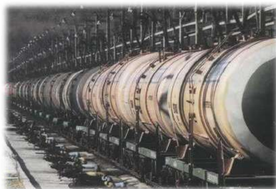
Рисунок 1.11- Сливо-наливная железнодорожная эстакада
