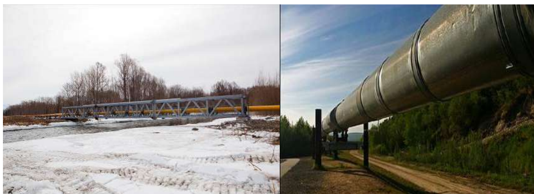
Рисунок 1.17 - Надземная прокладка трубопроводов
