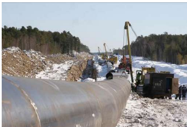
Рисунок 1.16- Сооружение подземного газопровода
