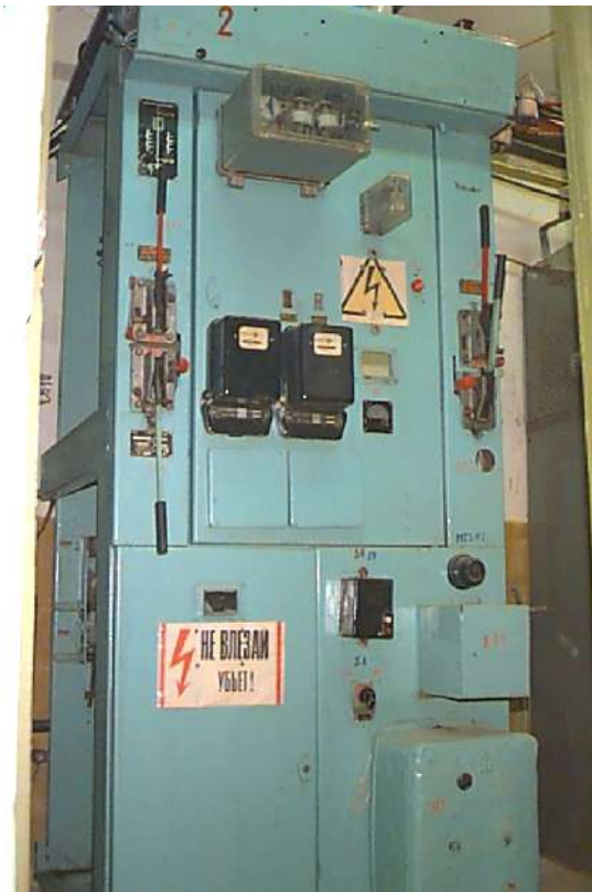
Рисунок 29 - Вид на ячейку КСО-285 спереди и сбоку (боковая панель снята).
