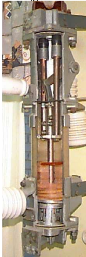
Рисунок 18 - Выключатели ВПМ-10, ВМП-10 и ВВТЭ-10.
