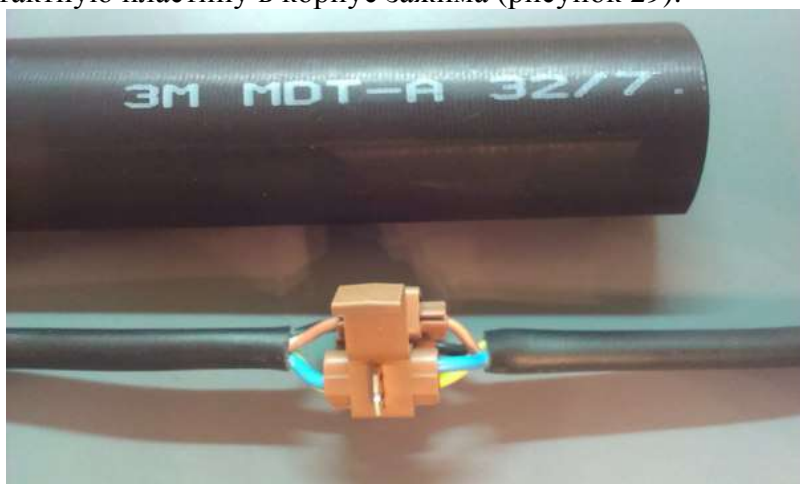
Рисунок 29 – Установка соединителей и контактной пластины
