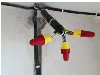
Рисунок 34 – Монтаж СИЗ
