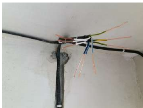
Рисунок 33 – Величина снятия изоляции
