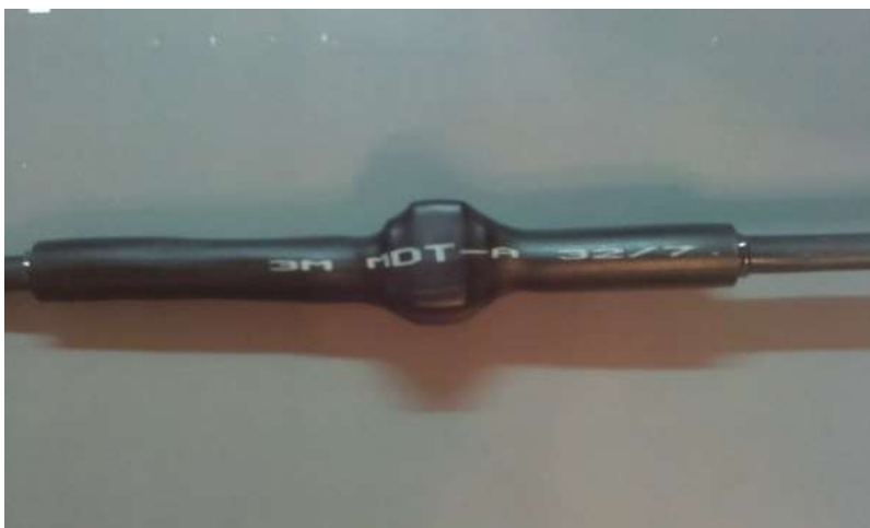
Рисунок 31 – Усаживание трубки
