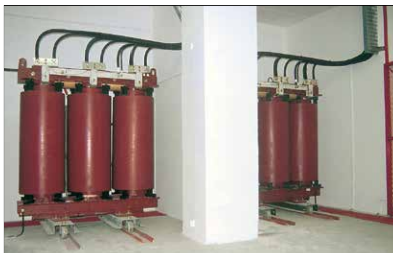
Стандартные присоединения ВН и НН сверху
