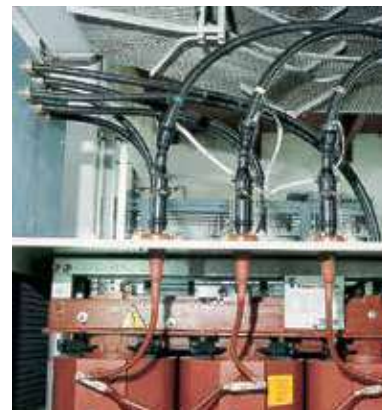
Присоединения ВН сверху через разъемы (1) (на заказ)
