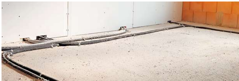
Прокладка электропроводки в гофрированной трубе, закрепленной хомутами
