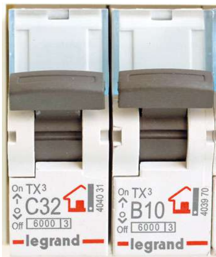
Примеры маркировки автоматических выключателей
