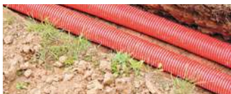
Прокладка кабелей в двустенных гибких электротехнических трубах
