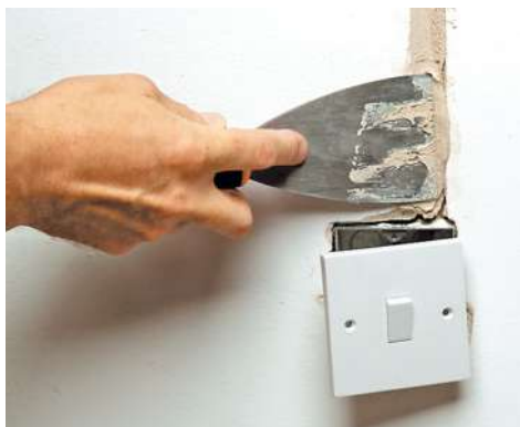
2. Заштукатурьте паз до электроустановочного устройства
