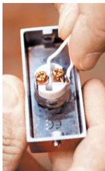
Подключение кнопки звонка
