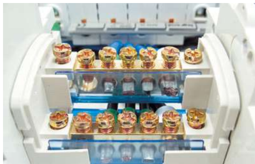
Двухполюсный кросс-модуль со снятой крышкой К верхней шине подведены нейтральные провода, к нижней – фазные
