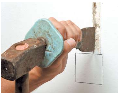
1. Сделайте в штукатурке паз для кабеля
