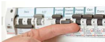
1. Отключите главный выключатель и включите автомат
