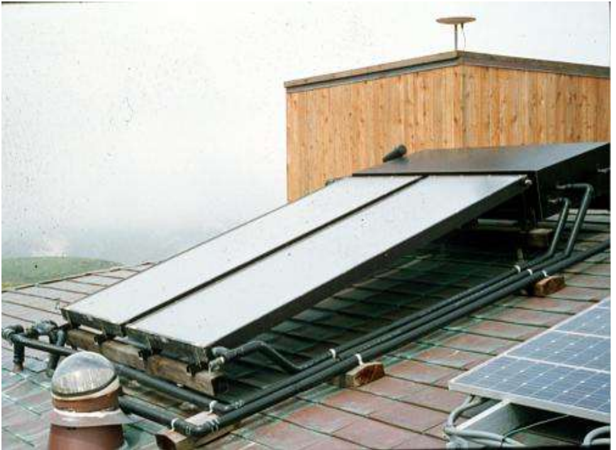
Рис. 3.1 Теплова система нагрівання води
