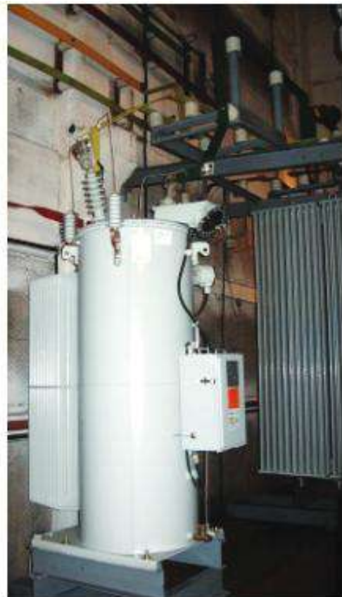
Рис. 2.7. Установка ВДТ на подстанции «Шахтинская» [13]
