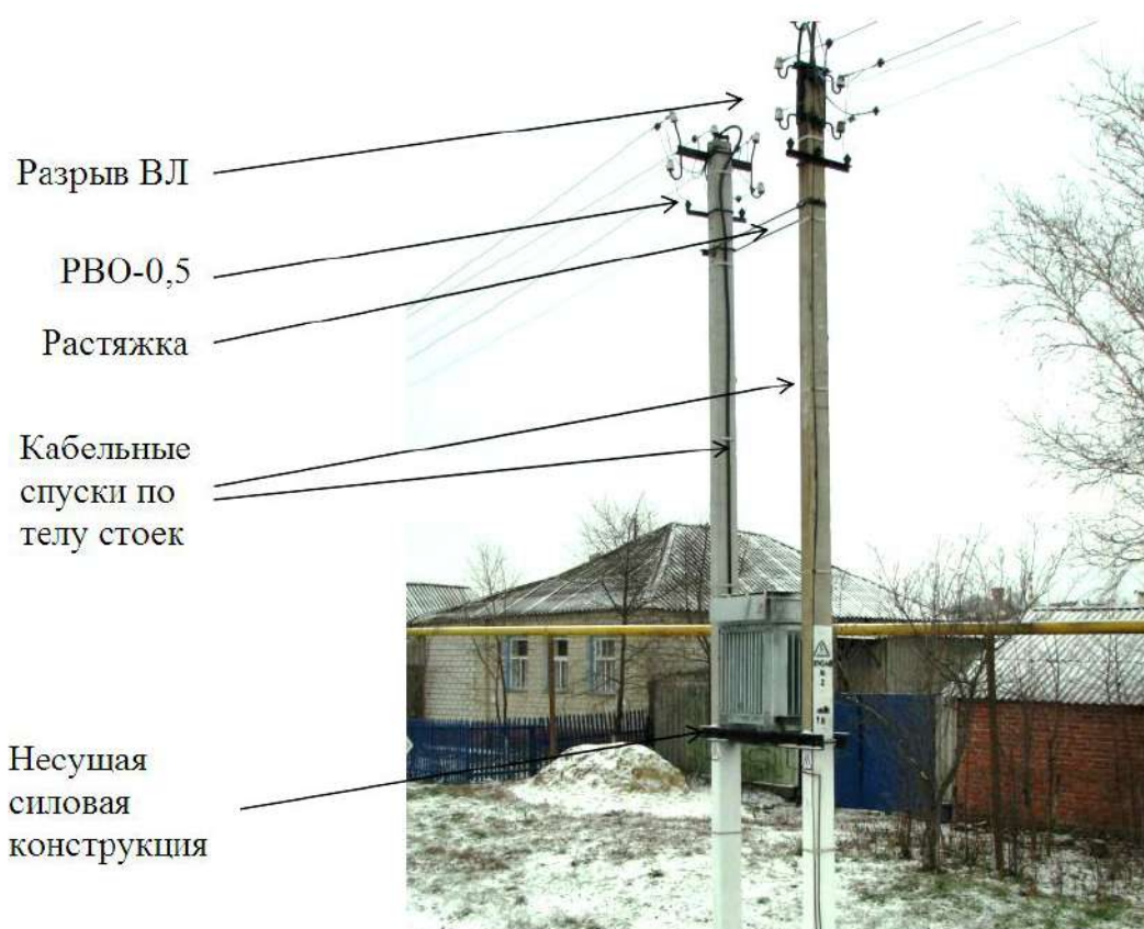
Рис. 2.16. Установка трансформатора ТВМГ на напряжение 0,4 кВ
