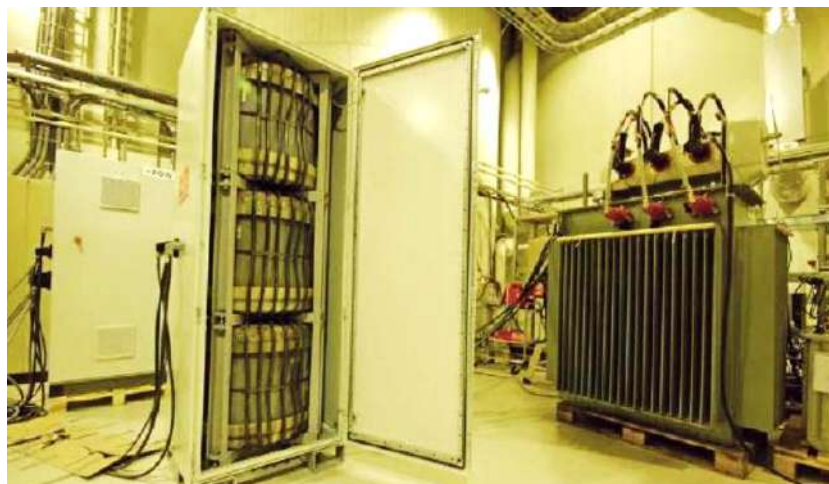
Рис. 2.13. Внешний вид трансформатора ТВМГ на напряжение 6–35 кВ
