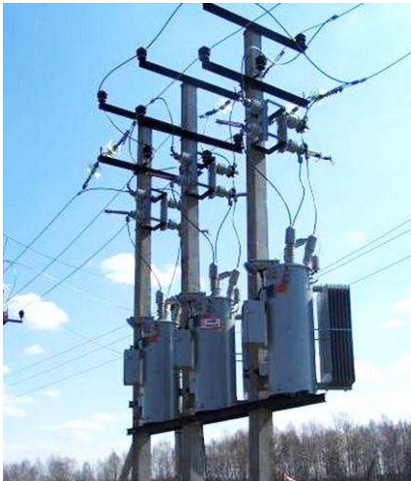
Рис. 2.5. Установка ПАРН на опоре
