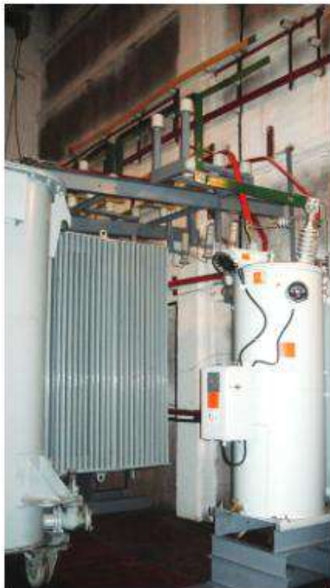
Рис. 2.7. Установка ВДТ на подстанции «Шахтинская» [13]
