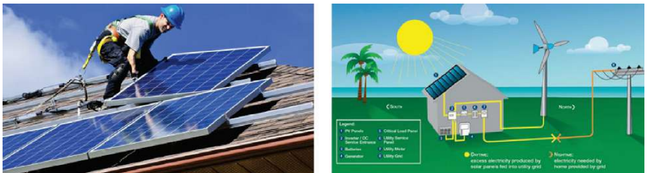
Рис. 13. Швидкий, рейковий монтаж сонячних панелей на даховій СЕС.
