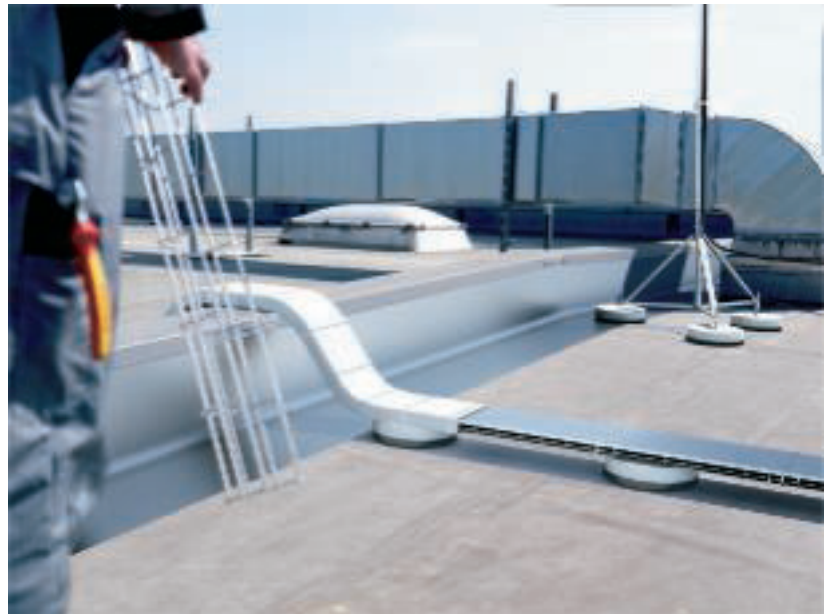
Мостик противопожарной стенки, защищенный огнестойким бандажом
