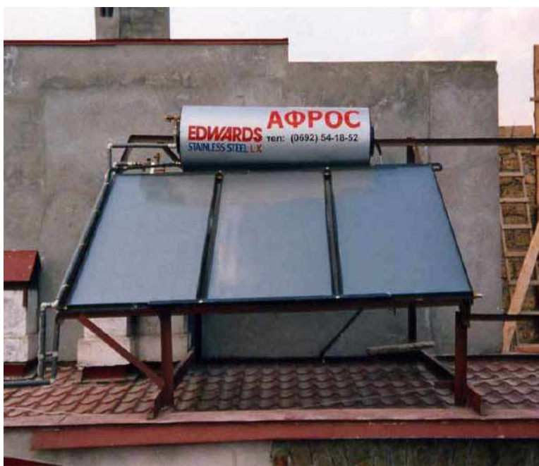
Малый маяк. Частная гостиница. S гелиополя 6 м2. Производительность 700 л/сутки.
