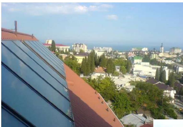
Алушта. Гелиосистема с площадью гелиополя 20 м 2 , производительностью 2000 л/сутки.
