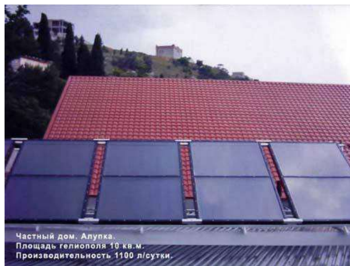
Рис. 1.6. Солнечные коллектора на крыше жилого дома. Фото ТПК «Афрос».
