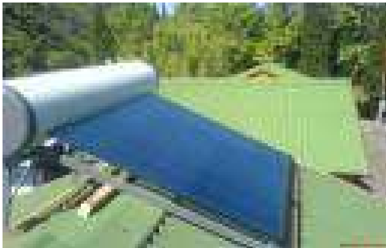
Рыбачье. Модульная гелиоустановка на вакуумных трубах производительностью 200 л/сутки.
