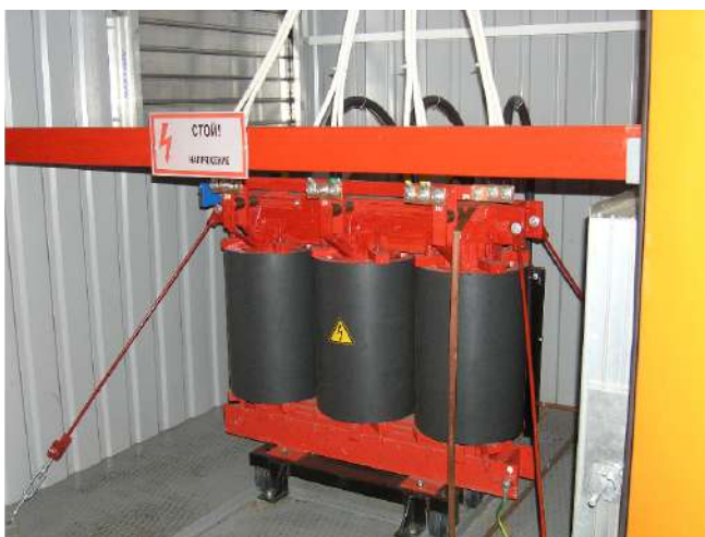
Трансформатор сухой.
