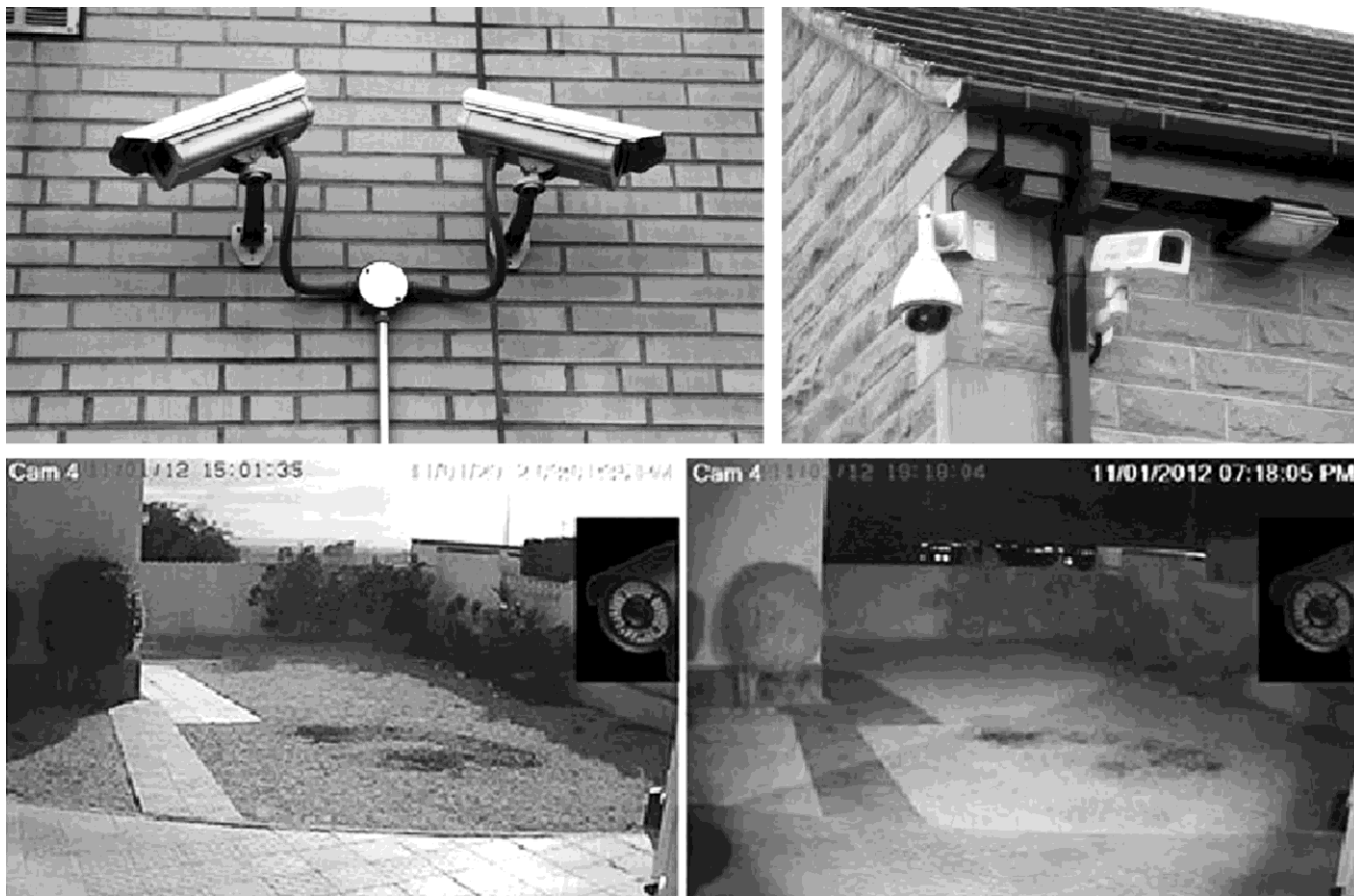
Рисунок 2 - Приклади встановлення відеокамер системи відеоспостереження
