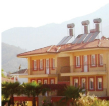
Рис. 17. Конструкция небольшой гелиосистемы с естественной циркуляцией теплоносителя в контуре гелиоколлектора – одноконтурная схема с верхним расположением бойлера
