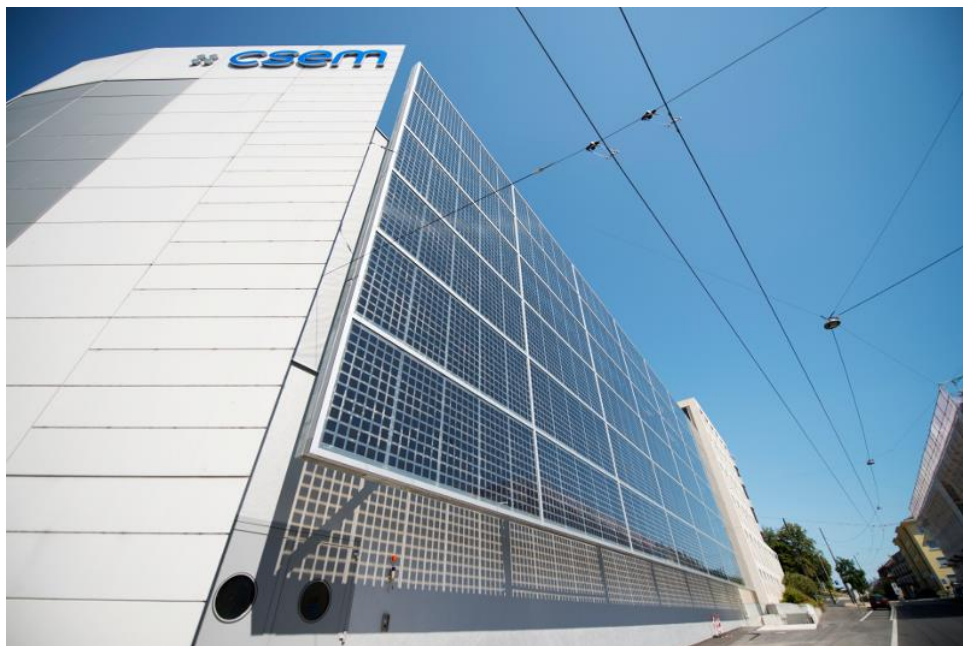
Рисунок 4.7 – BIPV-фасад в Швейцарии
