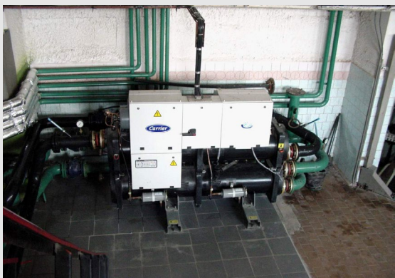
Фото 4. Тепловой насос «вода-вода» тепловой мощностью 200 кВт
