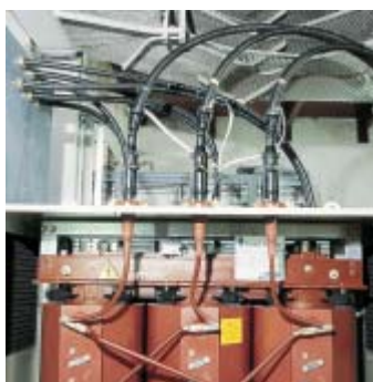
Рис.3.5. Присоединения ВН с использованием втычных разъёмов.
