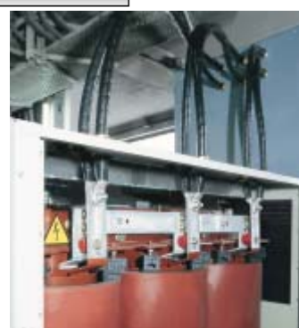
Рис.3.6. Стандартные присоединения ВН и НН сверху трансформатора защищенного исполнения.
