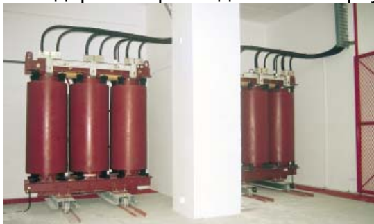
Рис.3.3. Стандартные присоединения ВН и НН сверху трансформатора открытого исполнения.
