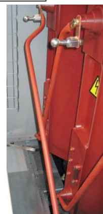
Рис.3.5. Присоединения ВН с использованием втычных разъёмов.
