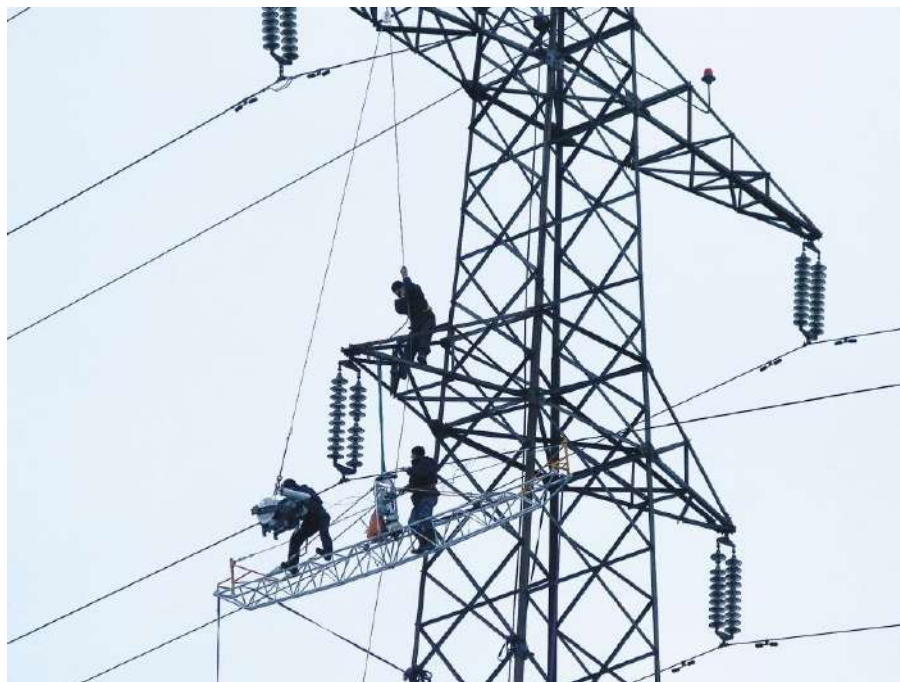
Рисунок 7.4.6 Использование рабочей платформы
