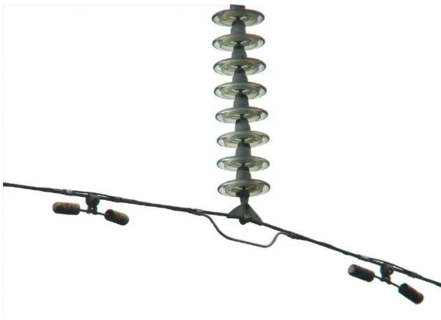
Рисунок 4.16.6 Обвод ОКНН поддерживающего изолятора ВЛ 110 кВ
