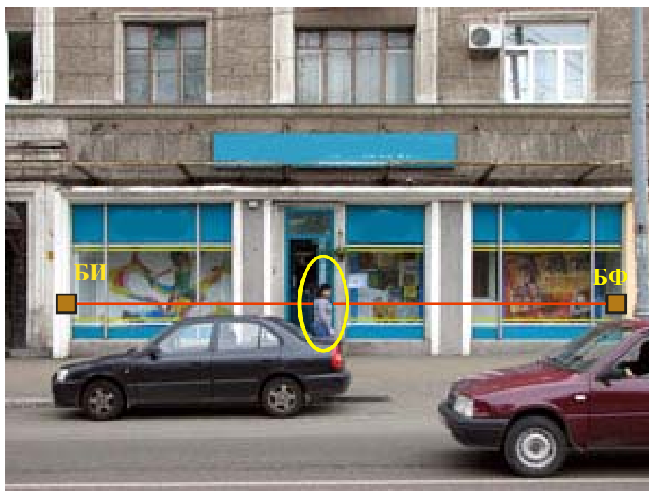
Рисунок 5.20 Не рекомендуемый вариант установки извещателя
