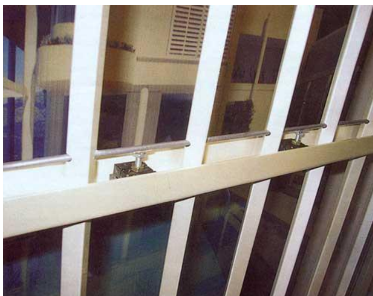
Рисунок 24 - Сенсорный кабель системы «INNO-FENCE», вмонтированный в специальную металлическую ограду
