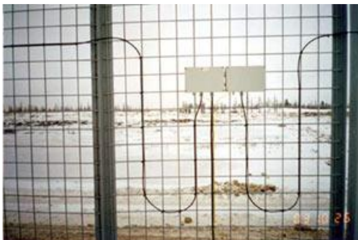
Рисунок 7 – Варианты установки системы «Defensor»
