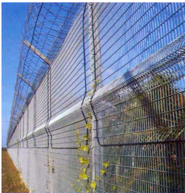
Рисунок 21 - кабель системы «Secure Fence» на сварной решетке
