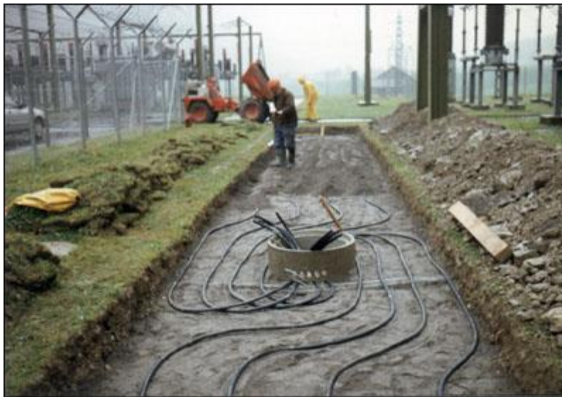
Рисунок 55 – Установка шлангов
