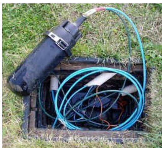
Рисунок 19 - Модуль системы «Secure Fence» в подземном колодце
