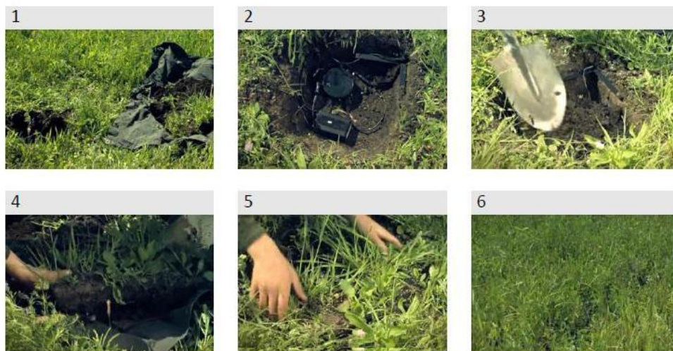
Рисунок 69 - Последовательность установки РС-У
