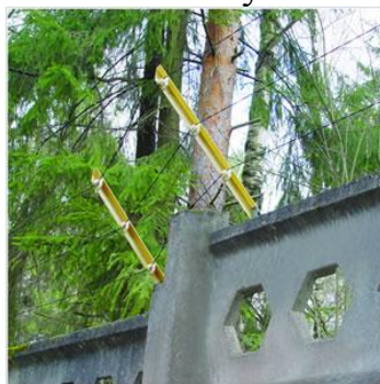
Рисунок 66 - ЧЭ комбинированного проводного извещателя «Дуэт»
