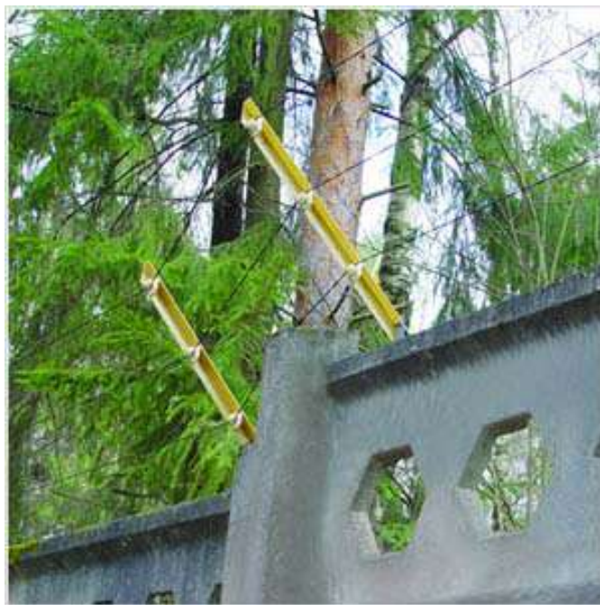
Рисунок 2.52 – ЧЭ комбинированного проводного извещателя «Дуэт»
