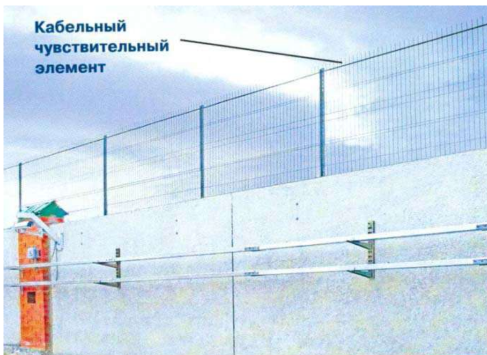
Рисунок 2.38 – Установка вибрационного извещателя
