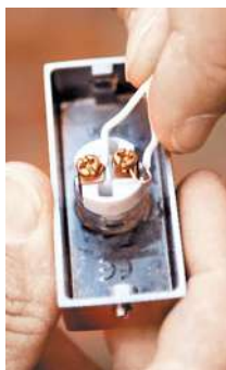
Подключение кнопки звонка
