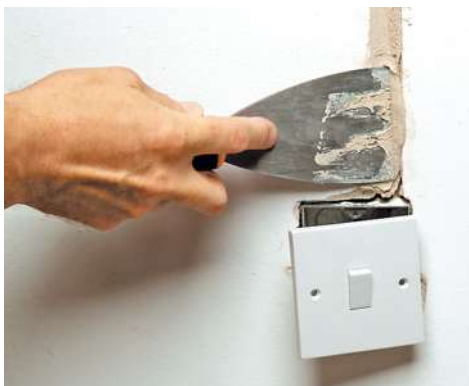
2. Заштукатурьте паз до электроустановочного устройства
