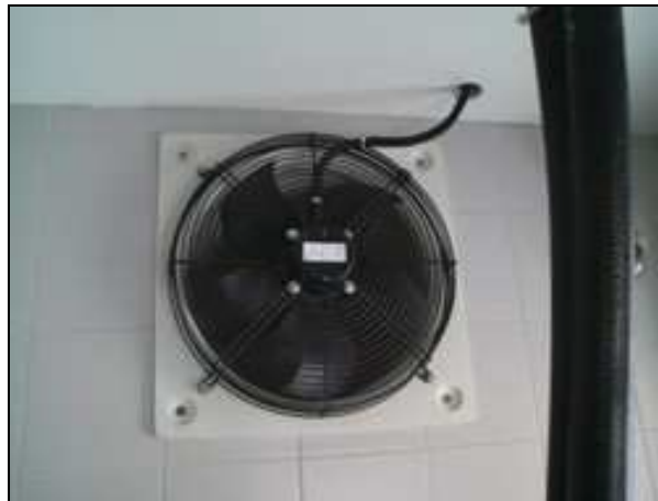
Рисунок 25. Система вентиляции помещения с термостатированием.
