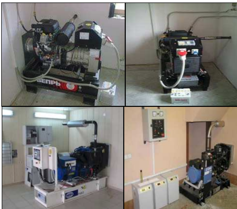
Рисунок 24. Установка генератора в помещении.
