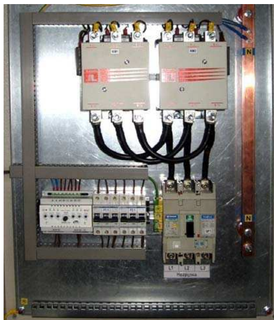
Рисунок 6. Электромеханический АВР.
