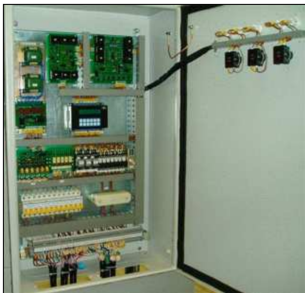
Рисунок 5. Тиристорный (электронный) АВР.
