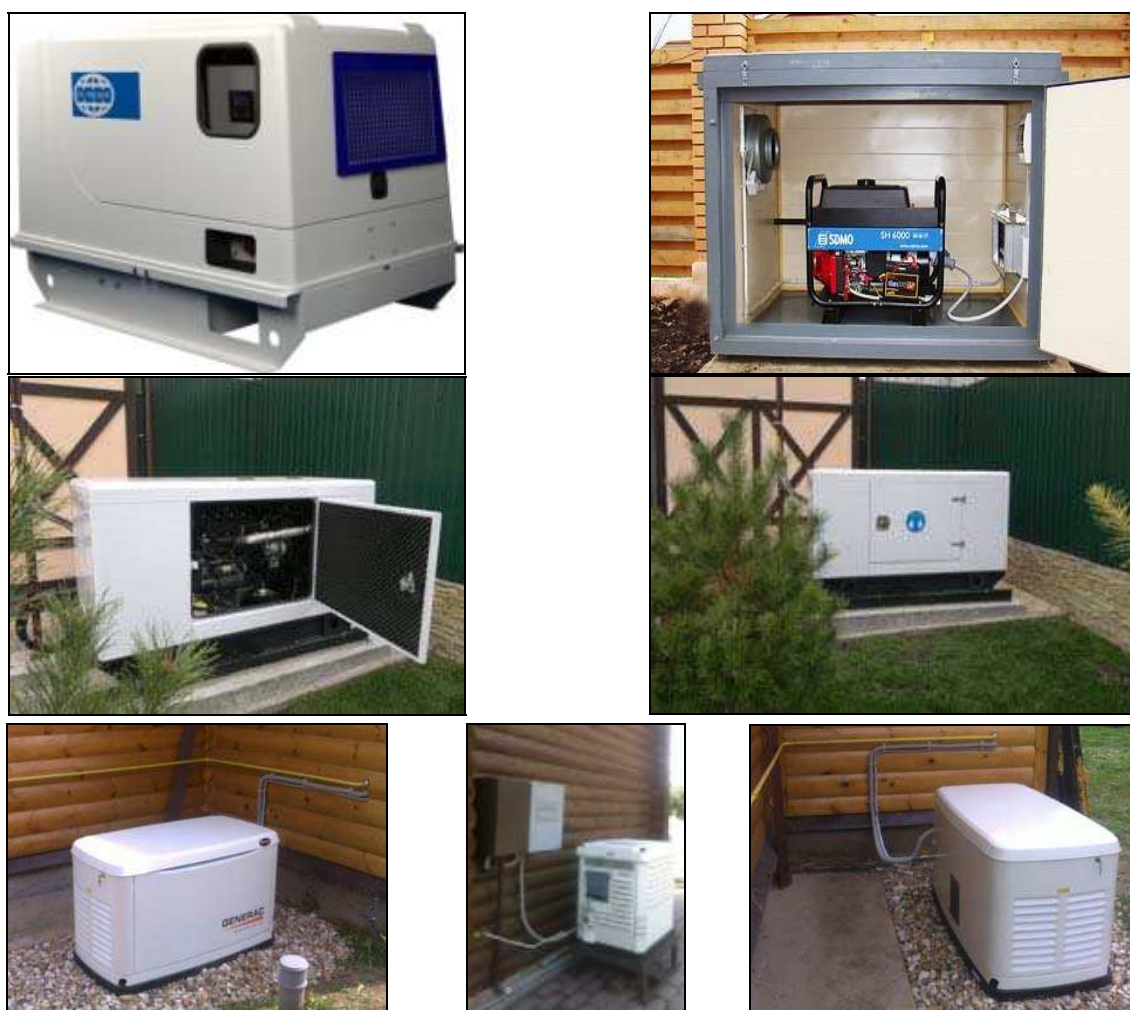
Рисунок 23. Примеры размещения электрических генераторов в контейнерах.
