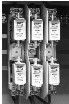
Рис. 7.3. Установка плавких предохранителей
