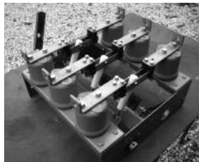
Измерения и испытания разъединителей включают следующие виды работ. Рис. 4.2. Разъединитель напряжением 10 кВ
