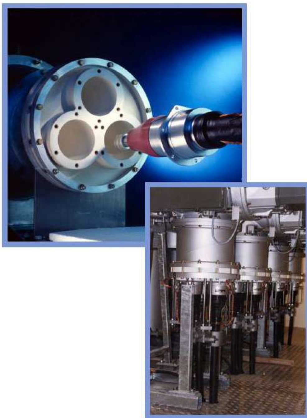
Рис. 5.16. Газонепроницаемое компактное концевое уплотнение кабеля
