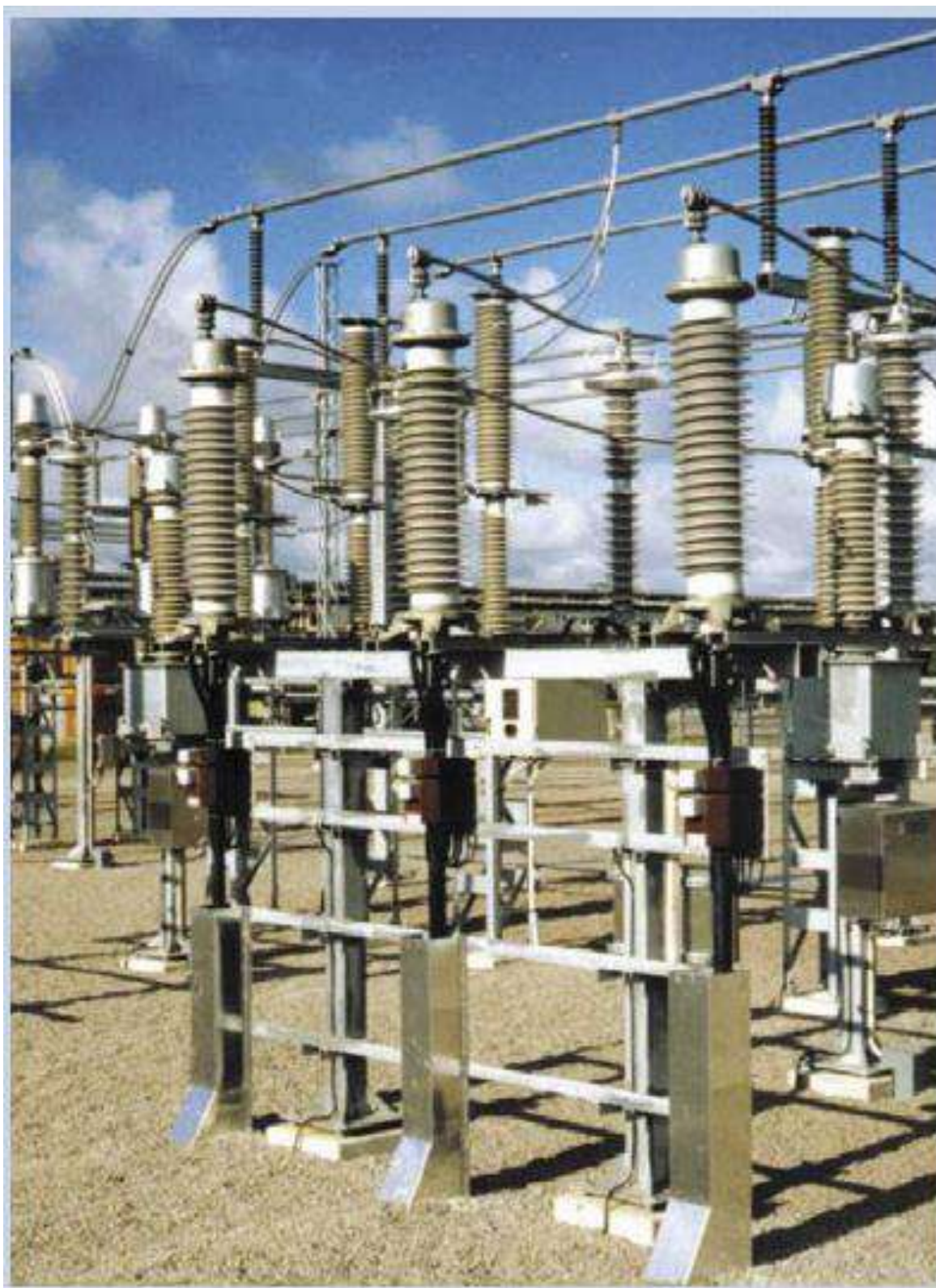
Рис. 5.31. Переход КЛ-110 кВ на ОРУ-110 кВ подстанции
