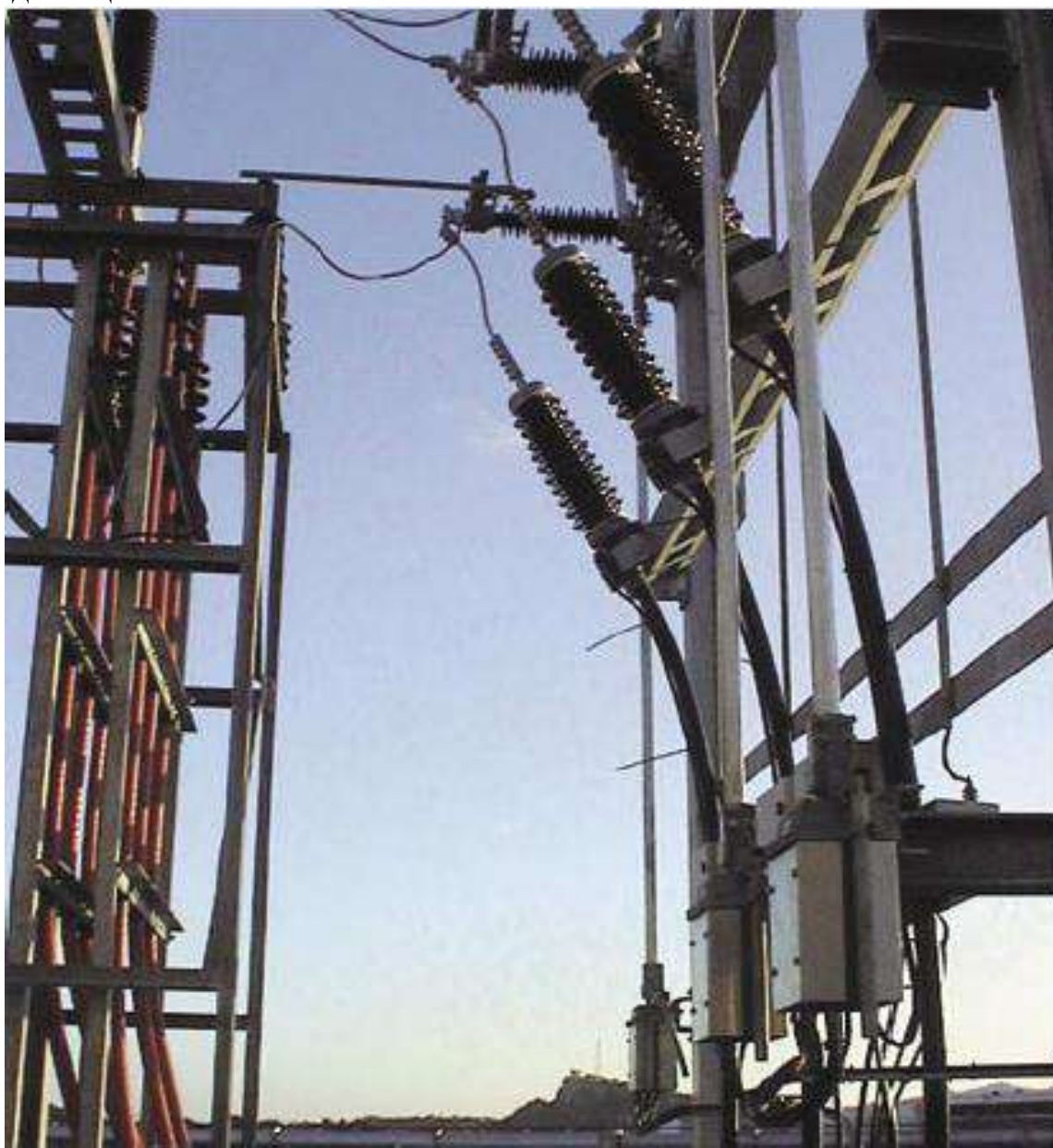
Рис. 5.30. Переход КЛ-110 кВ на ОРУ-110 кВ подстанции
