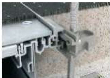
Установлена профили для стыковки с напольным покрытием
