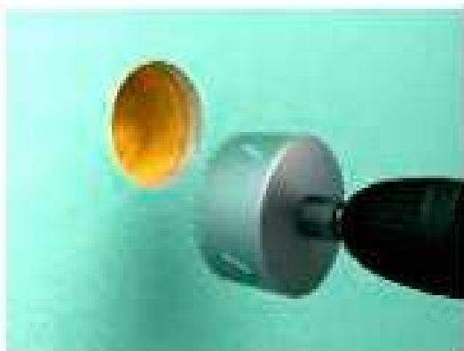
Рисунок 4.9.1 – Высверливание гнезда под установку установочных коробок
