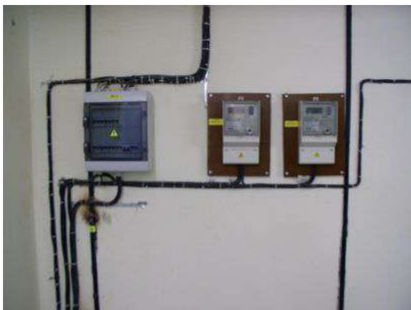
Рисунок 4.3.3 - Электропроводки открыто непосредственно по строительным основаниям
