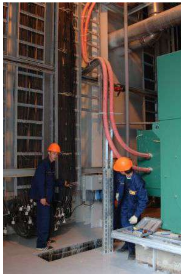
Рисунок 4.7.12 - Монтаж электропроводок на лотках
