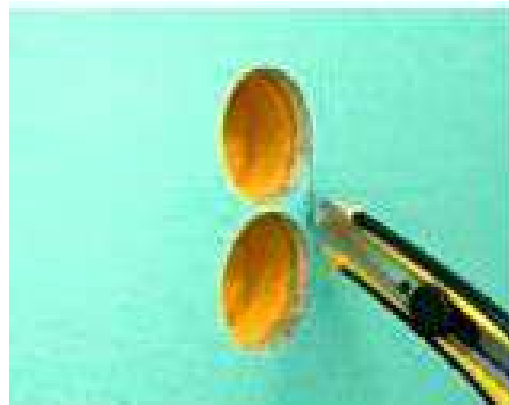
Рисунок 4.9.1 – Высверливание гнезда под установку установочных коробок
