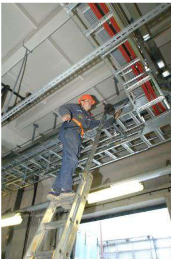
Рисунок 4.7.12 - Монтаж электропроводок на лотках
