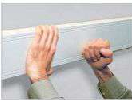
Рисунок 4.6.5 - Установка коробов
