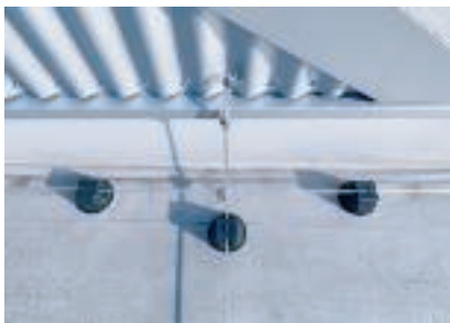
Соединение металлического фасада с системой молниезащиты
