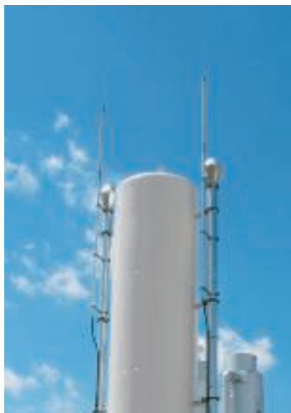
Система isCop® в выхлопной зоне биогазовой установки
