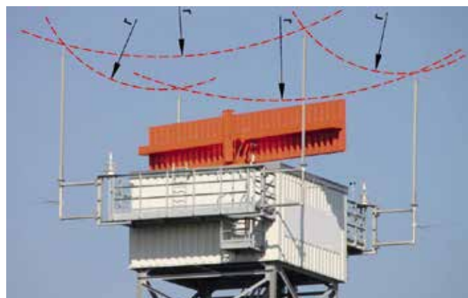
Рисунок 9. Пример использования метода фиктивной сферы.
