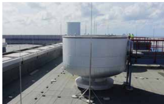
Рисунок 3. Использование стержневых молниеприёмников для защиты кровельных надстроек.
