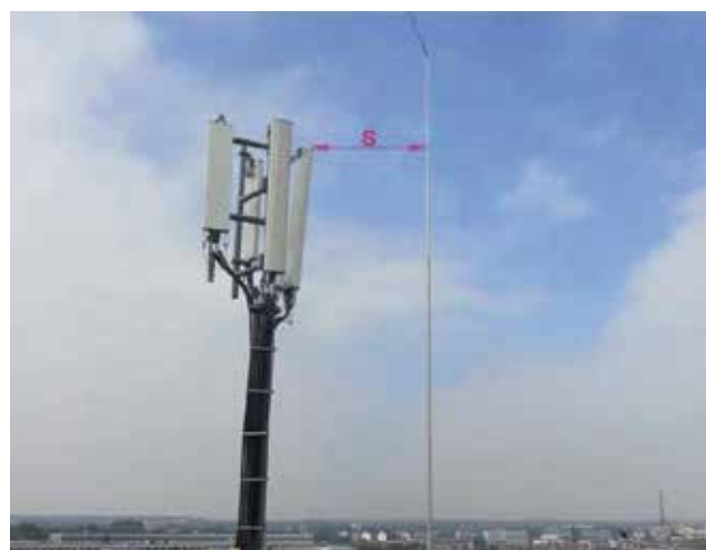
Рисунок 13. Пример использования безопасного расстояния.
