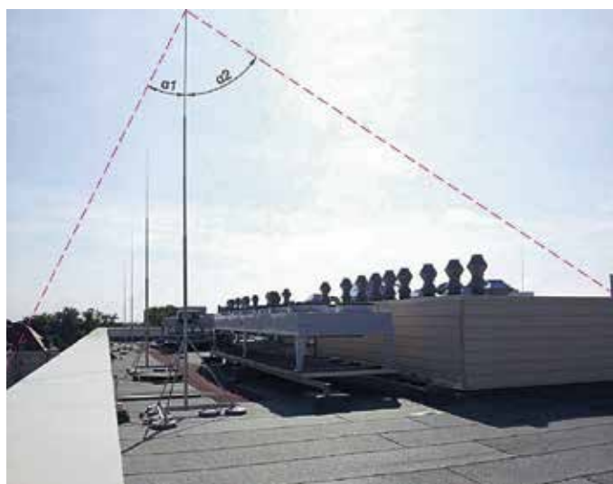
Рисунок 12. Пример использования метода защитного угла.
