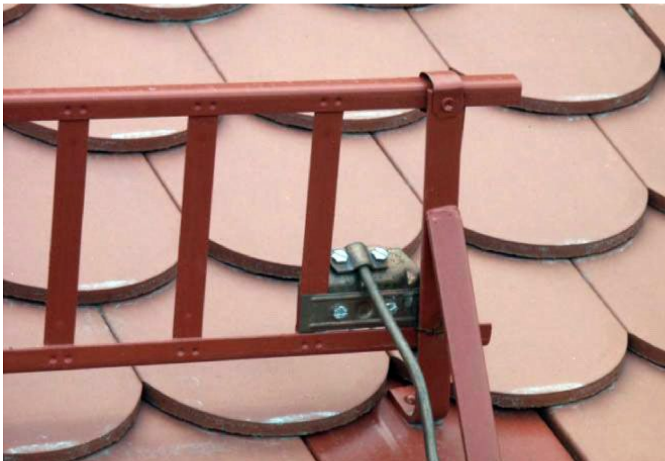
17. Зажимы для крепления проводников к водосточным желобам.
