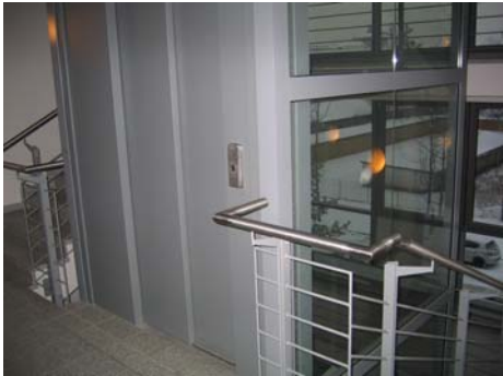
Рис. 7.1.5.7.а) и б). Шахта из алюминиевого профиля с остеклением.
