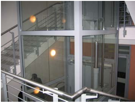
Рис. 7.1.5.6. Стеклопанельная шахта - аквариум. (Берлин, Германия)
