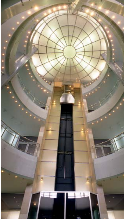
Рис. 7.1.5.8. Открытая шахта для панорамного лифта.
