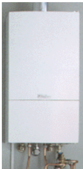
рис. 1.3 Настенный газовый водогрейный котёл
