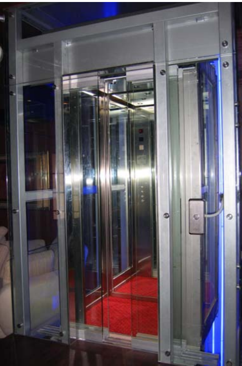
Рис. 7.1.5.5. Металлокаркасная шахта с остеклением. Крепление с помощью специальных болтов.
