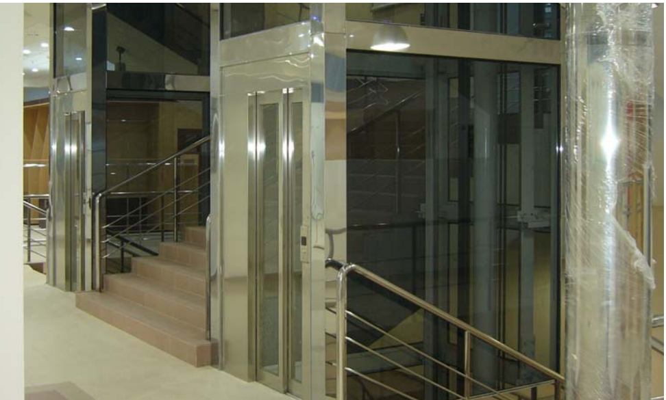
Рис. 7.1.5.5. Металлокаркасная шахта с остеклением. Крепление с помощью специальных болтов.
