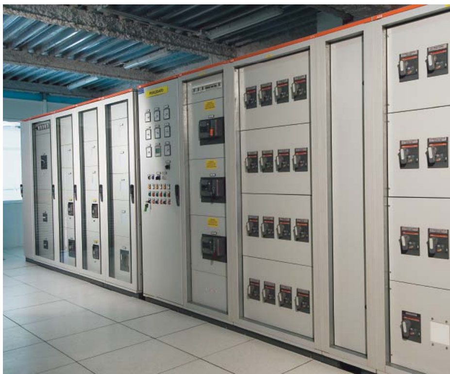
Рисунок 2.13: Главный распределительный щит (пример).
