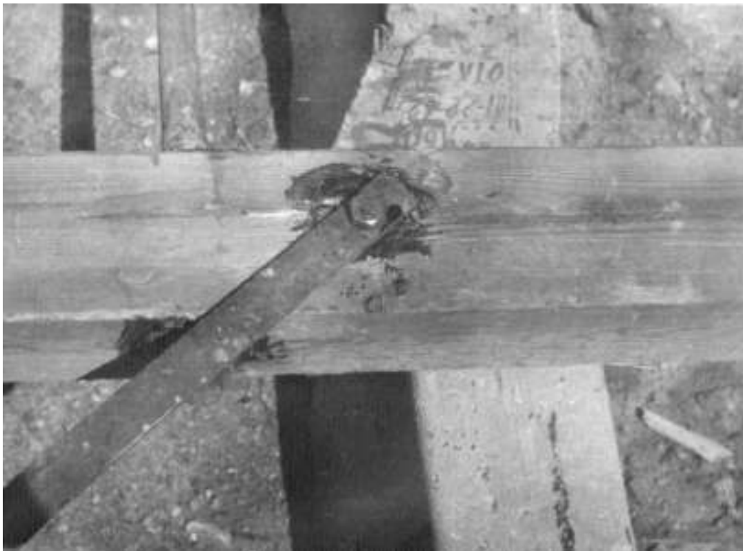
Фото 56. Защита поверхности траверсы герметиком между штырем и укосиной
