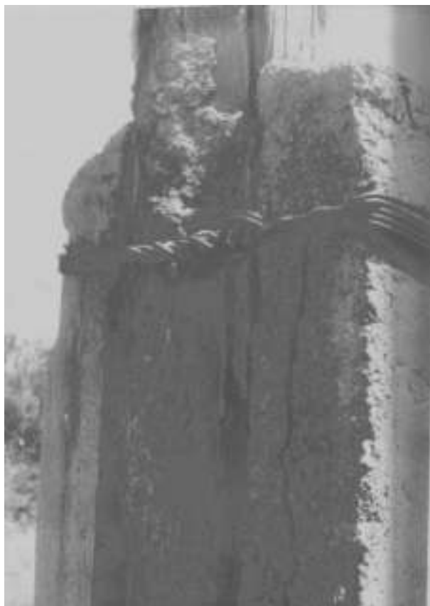
Фото 5. Поражение опоры термитами
