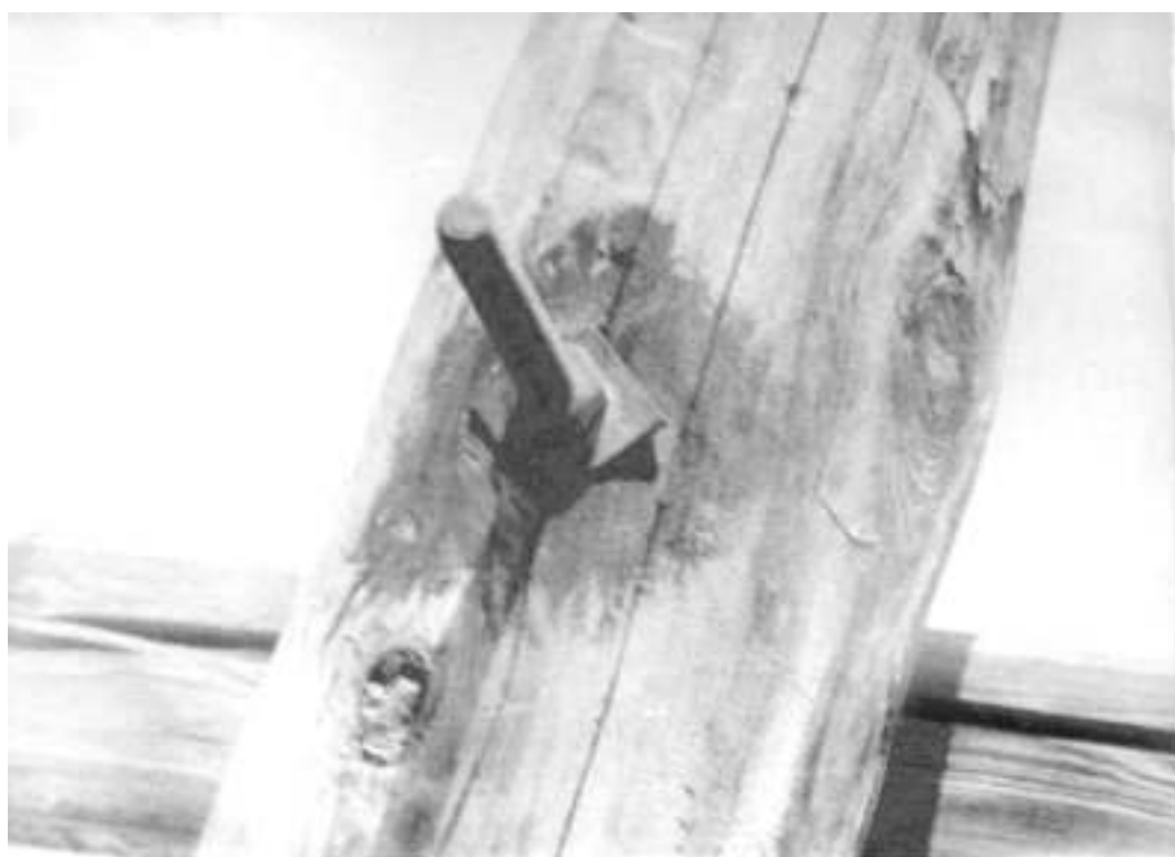
Фото 53. Защита поверхности опоры эпоксидной смолой в зоне центрального болта крепления траверсы к опоре
