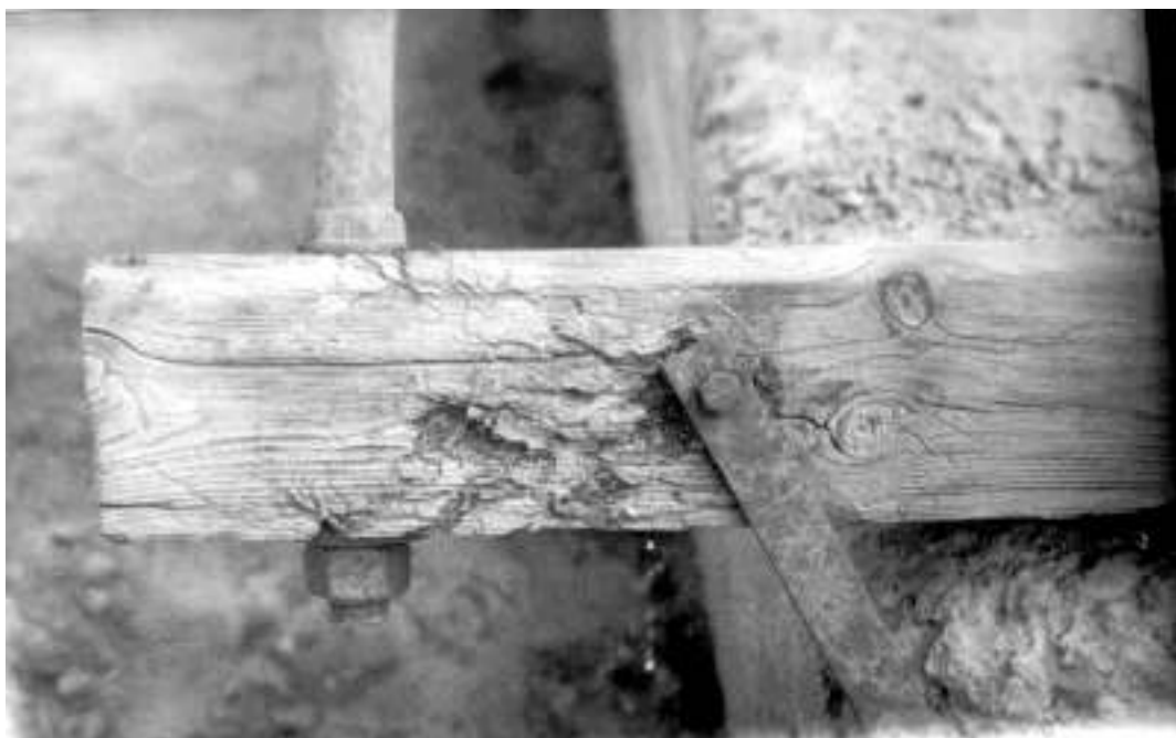
Фото 21. Образование треков на поверхности траверсы под штырем. Дефект № 5
