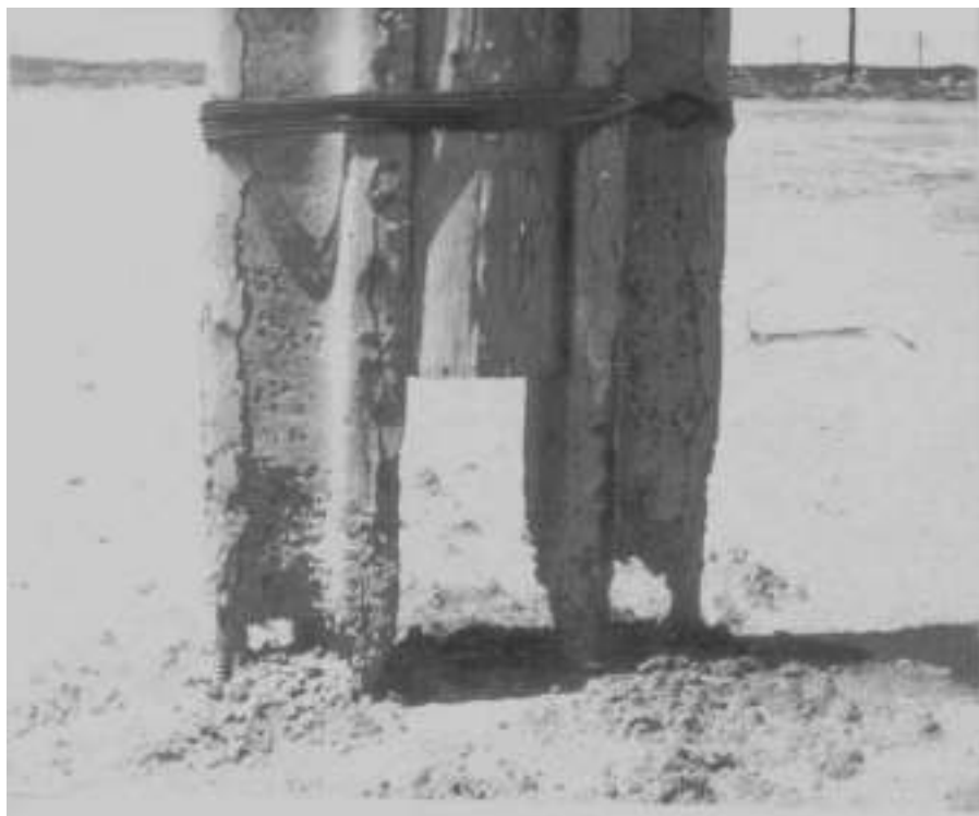
Фото 7. Коррозионное разрушение железобетонного пасынка на участке Абадан - Кырк – Кыз
