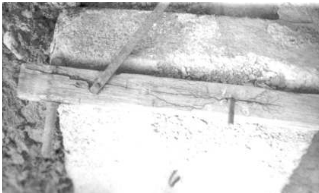
Фото 23. Развитие трещин на боковой поверхности траверсы между металлическими элементами. Дефект № 7
