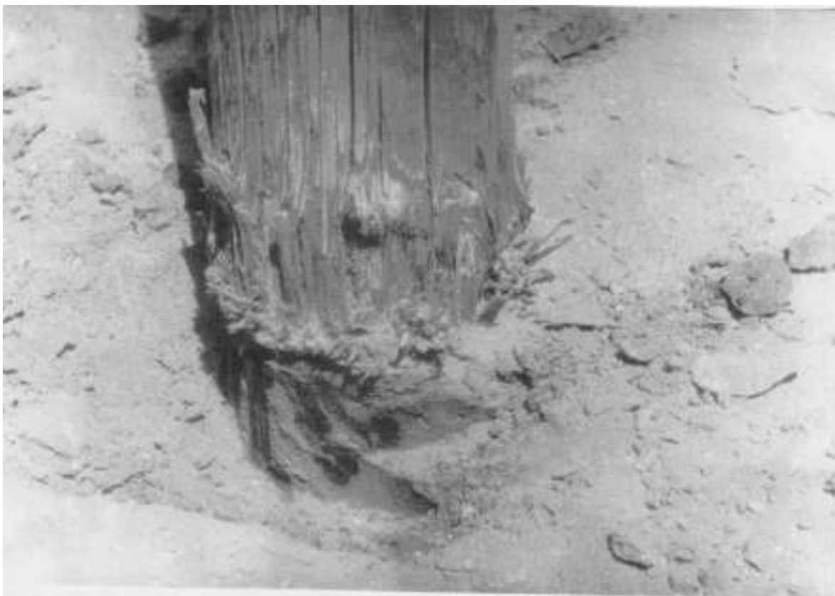
Фото 15. Разрушение древесины опоры солями у поверхности земли. Участок ВЛ - 10 кВ Айдан - Рзд. 121. 1991 г.
