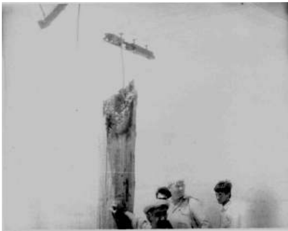
Фото 29. Последствия возгорания опоры двухцепной ВЛ 10 кВ от токов утечки на участке Айдин – Рзд. 121. Май 1991 г.
