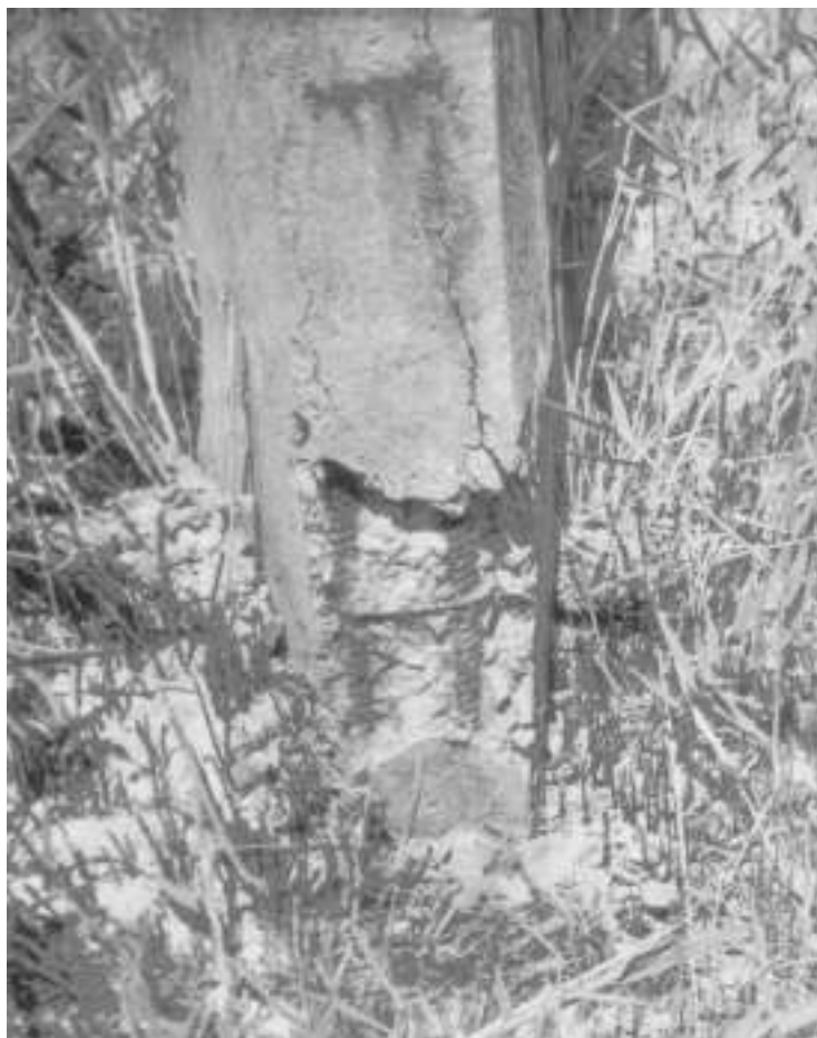
Фото 13. Разрушение защитного слоя бетона пасынка опоры установленной на поливных землях. Участок Раушан – Кунград
