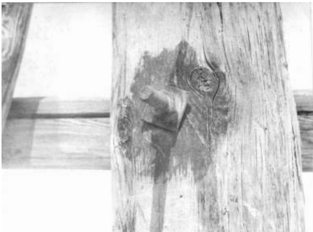
Фото 54. Защита поверхности А – образной опоры эпоксидной смолой
