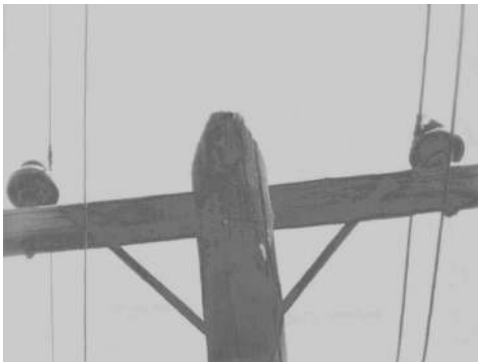
Фото 2. Биоразрушение верхней части стойки опоры
