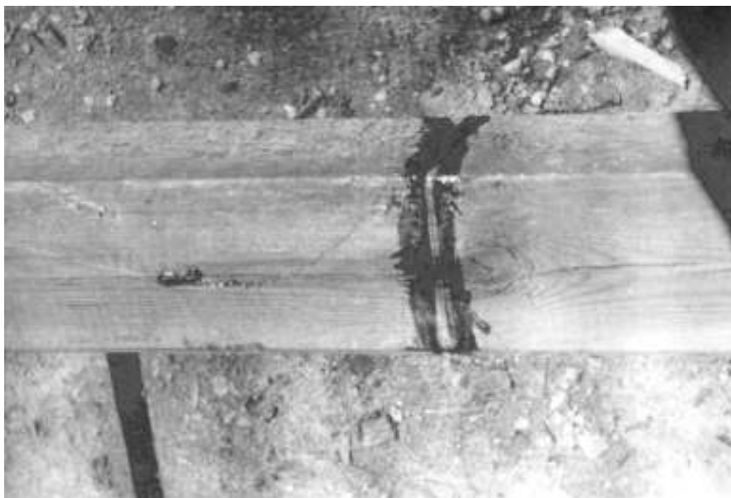
Фото 55. Защита поверхности траверсы герметиком в зоне крепления укосины
