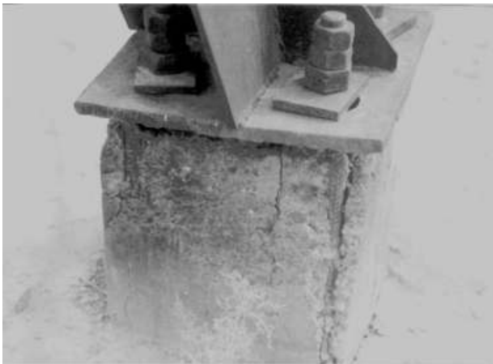
Фото 11. Разрушение фундамента металлической опоры на ст. Абдан ВЛ – 10 кВ
