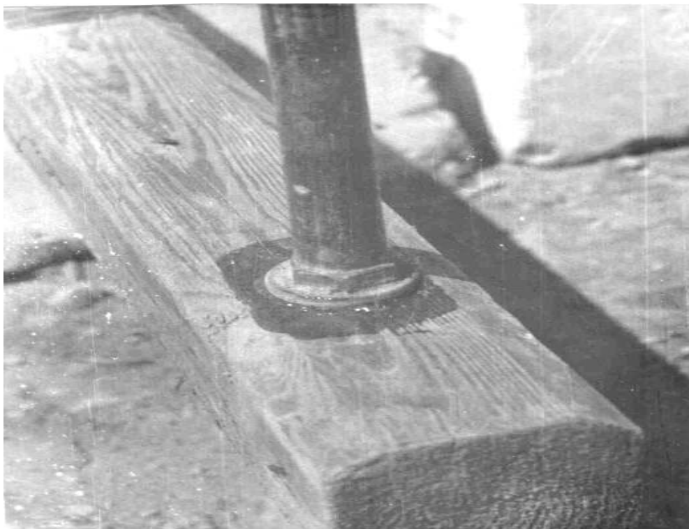
Фото 58. Защитная обработка поверхности траверсы герметиком в зоне штыря
