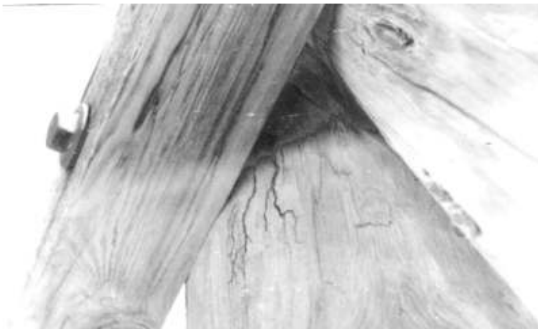
Фото 17. Образование треков под траверсой у центрального болта крепления траверсы к опоре. Дефект № 1
