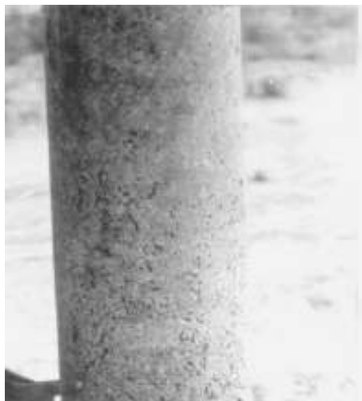
Фото 9. «Выветривание» цементного камня с обнажением заполнителя бетона железобетонной опоры одноцепной ВЛ – 10 кВ на участке Абадан-Кырк-Кыз
