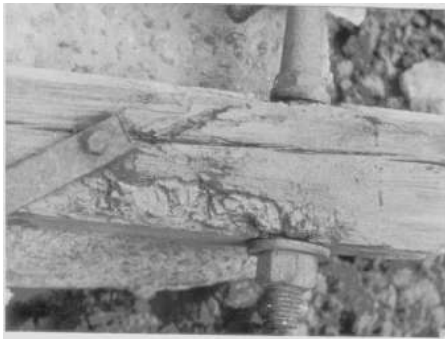
Фото 15. Разрушение древесины опоры солями у поверхности земли. Участок ВЛ - 10 кВ Айдан - Рзд. 121. 1991 г.
