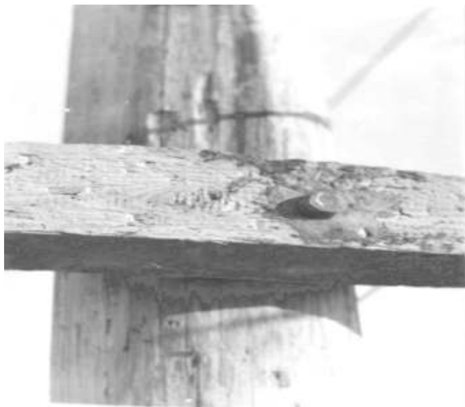
Фото 52. Эпоксидная смола защищает зоны крепления траверсы к опоре
