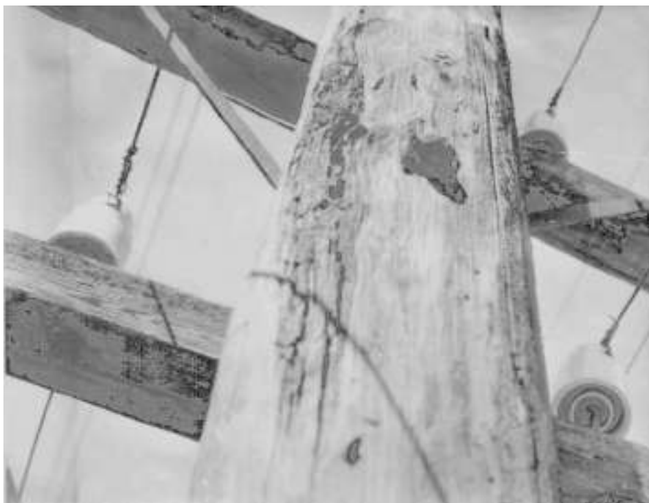
Фото 4. Прогрессирующий очаг биоразрушения стойки опоры на участке ВЛ 10 кВ (Рзд. 13, км 3612)
