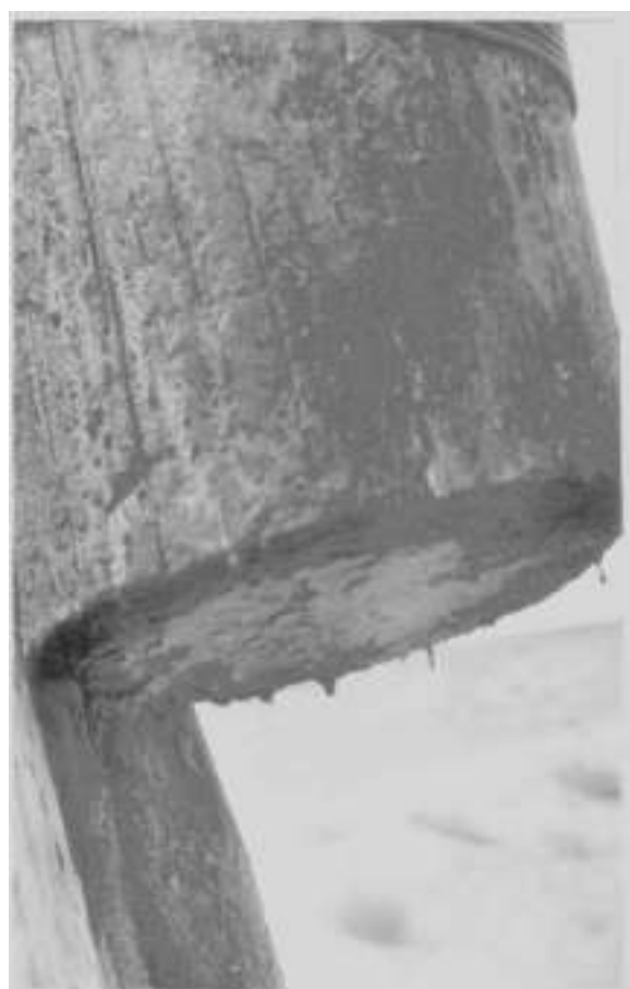
Фото 8. Креозотовая пропитка опоры вытекает из клеток древесины под действием солнечной радиации
