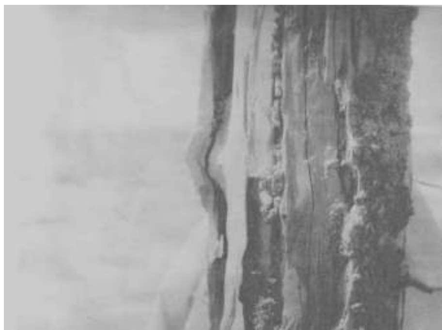
Фото 6. Разрушение древесной опоры термитами. Лепки термитов на поверхности древесины
