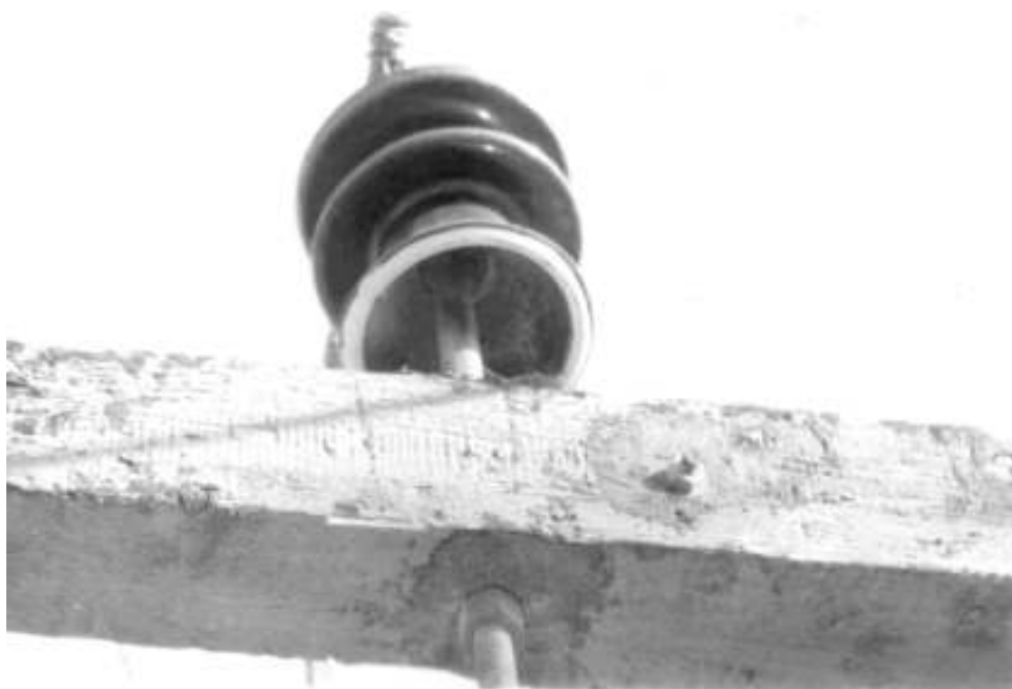
Фото 59. Способы защиты траверсы эпоксидной смолой в зонах крепления штыря к укосине
