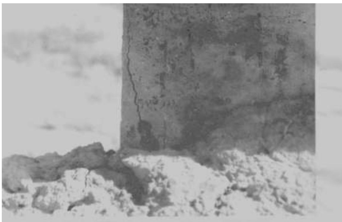
Фото 10. Продольные трещины в центрифугированных опорах ВЛ – 10 кВ. Участок Абадан-Кырк-Кыз
