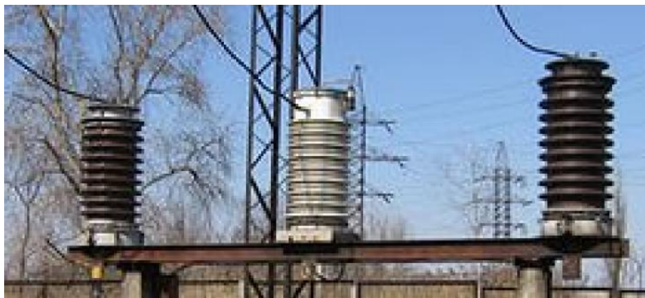
Рисунок 57. Трансформаторы напряжения типа НКФ-110.
