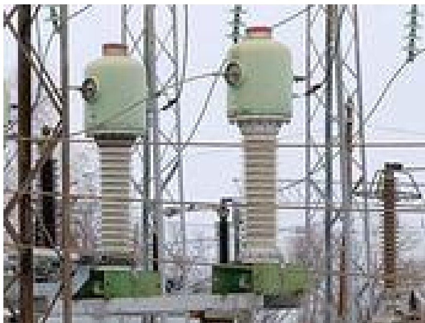
Рисунок 51. Трансформаторы тока типа ТФНД-110.
