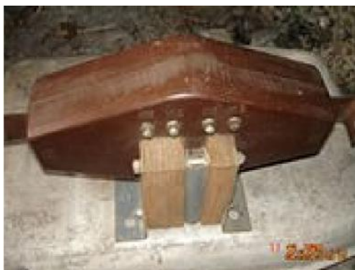
Рисунок 49. Трансформатор тока с двумя сердечниками и двумя вторичными обмотками типа ТПОЛ-10.
